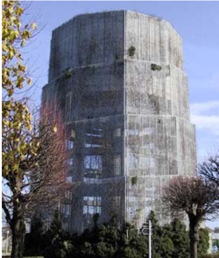
Le château d'eau des Quatre pavés Christian de Portzamparc, 1976
