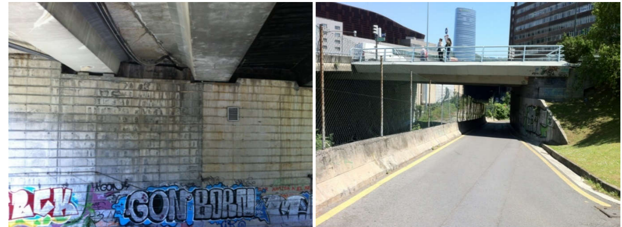
Dos imágenes del paso Oeste (lado Olabeaga) sobre la plataforma de Adif y vial de acceso al aparcamiento del edificio Euskalduna. En la imagen superior se aprecia la tipología de tablero de vigas artesas con prelasas prefabricadas.
