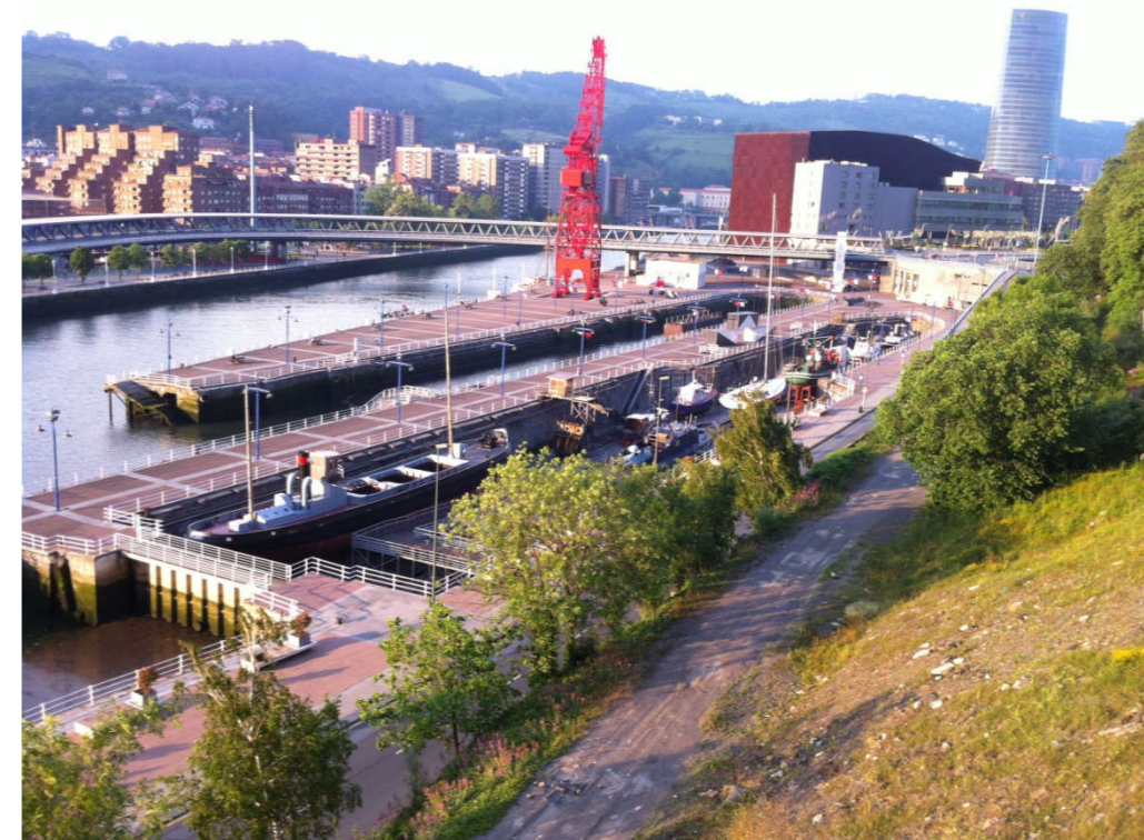
Imagen desde la calle Camino de Ventosa, hacia la plataforma en desuso de Adif por la que circulará el tranvía. Además se observa el dique seco y dique húmedo de los muelles Ramón de la Sota. Detrás, se observa el Puente Euskalduna.
