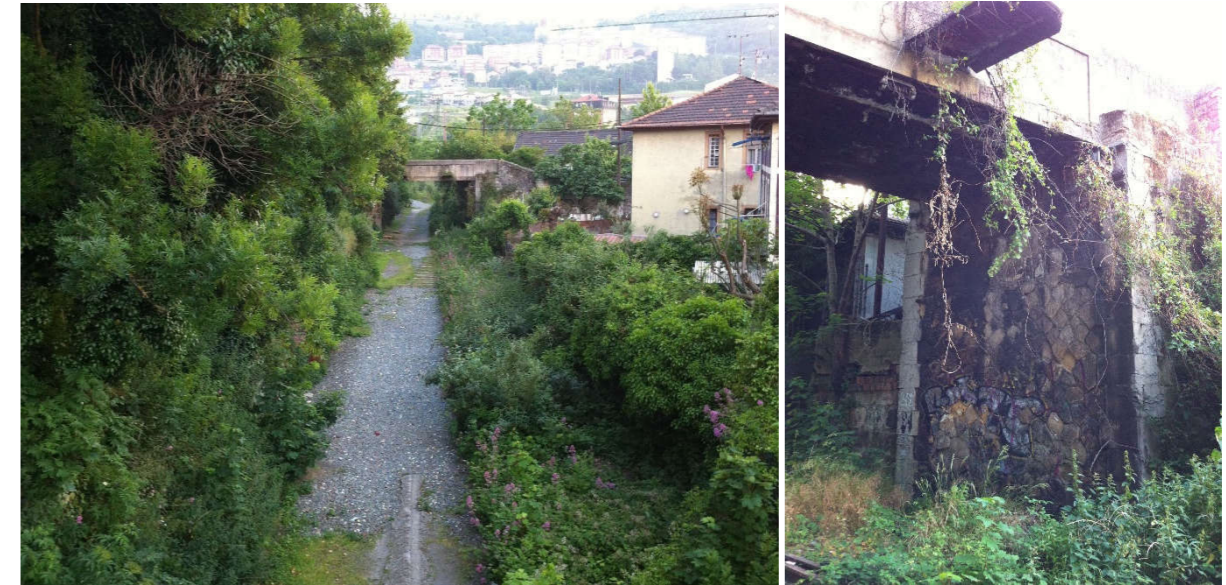
En la imagen de la izquierda se aprecia la plataforma ferroviaria de Adif sobre la que se instalará la nueva plataforma tranviaria. Al fondo de la imagen se encuentra la posición de la parada de Olabeaga a la altura de la pasarela existente que se afectará y será necesaria su reposición. En la imagen de la derecha se puede observar el apoyo de fábrica de lado ría y el tablero de la pasarela existente.
