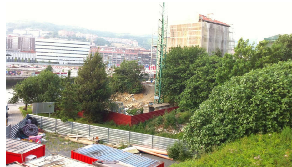
Imagen del año 2016 en la que se aprecia la ubicación de las estructuras de acceso al puente sobre la ría del tranvía. La traza discurrirá sobre la zona vallada a unos 8 m de cota por encima del terreno natural que se puede observar.
