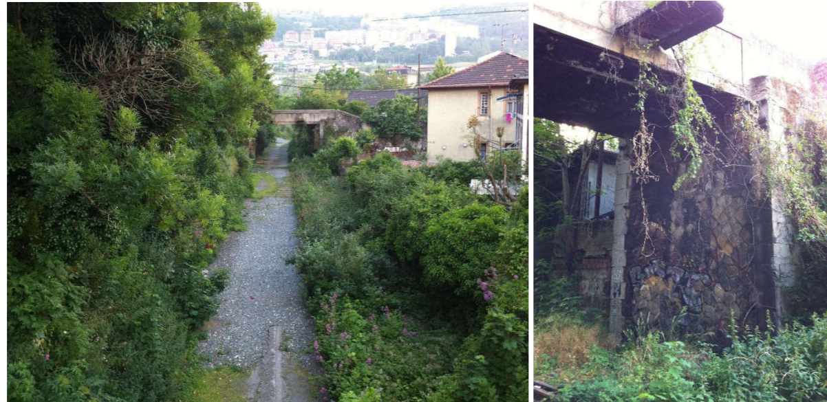
Ezkerreko irudian Adifen tren-plataforma ikus daiteke, eta horren gainean jarriko da tranbiaren plataforma berria. Irudiaren hondoan Olabeaga geltokiaren kokalekua dago, egungo pasabidearen parean. Pasabidean eragina izango du eta ordezkatu egin beharko da. Eskuineko irudian ibaiaren alboko fabrika eta egungo pasabidearen taula ikus daitezke.
