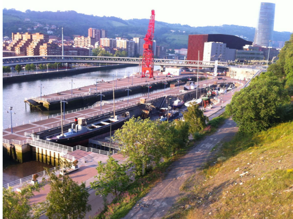
Ventosa kaletik ateratako irudia, tranbia igaroko den Adifen plataformarantz. Gainera, Ramon de la Sota kaietako dike lehorra eta dike hezea ikusten dira. Atzean, Euskalduna Zubia ikus daiteke.
