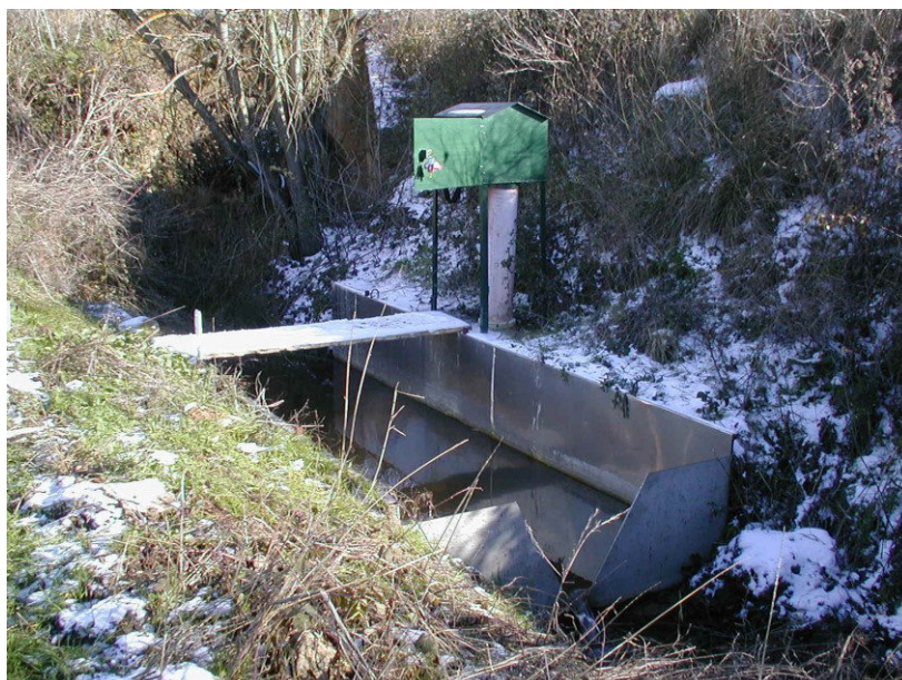
Figura 8 Aspecto de la estación de aforo Arreo Entrada (Vertedero Triangular 60°).
