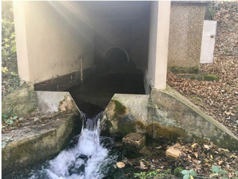
Figura 1 Estación de aforo SA02-Manantial El Soto.
