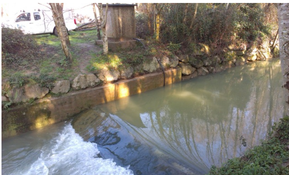
Fig. 2.1.- Estación de aforo tipo. Vertedero Crump modificado (SA06-Manantial Olalde)
