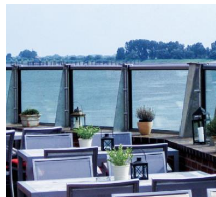
Barandilla acristalada resistente al empuje del agua
