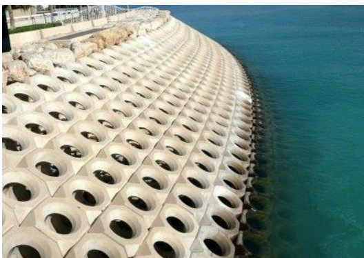
Estructura de disipación de energía en la isla de Burj Al Arab
