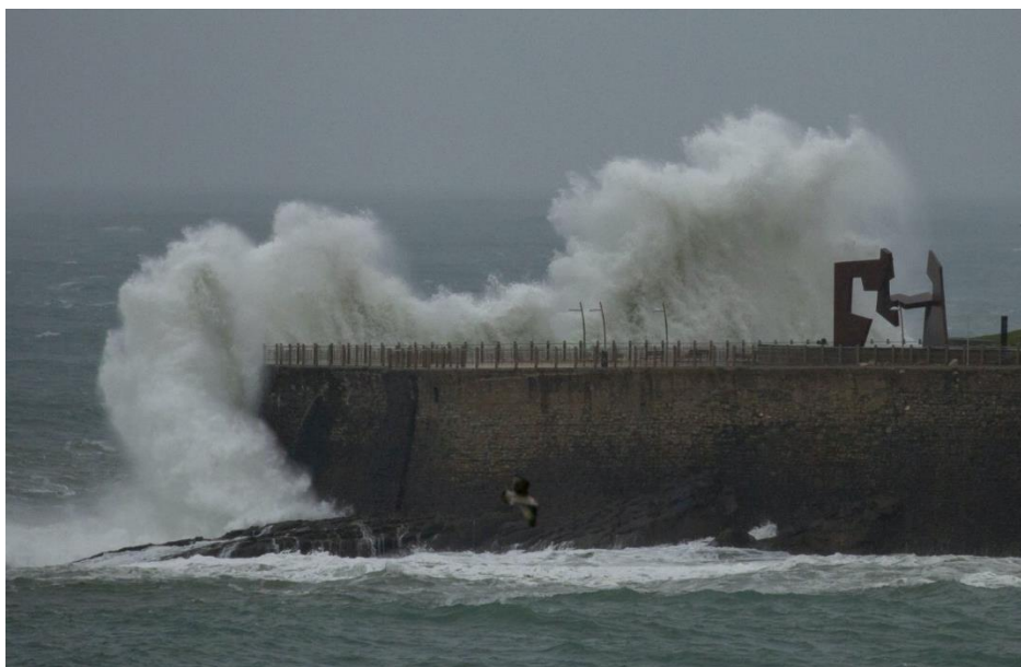
Choque e Inundación por ola en un muro de costa. Paseo Nuevo de Donostia.
