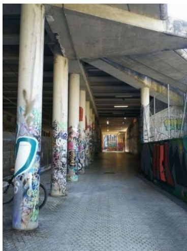
Ilustración 10: Estructura soporte de plaza superior (Peñas de Aia) y acceso inferior al polideportivo
