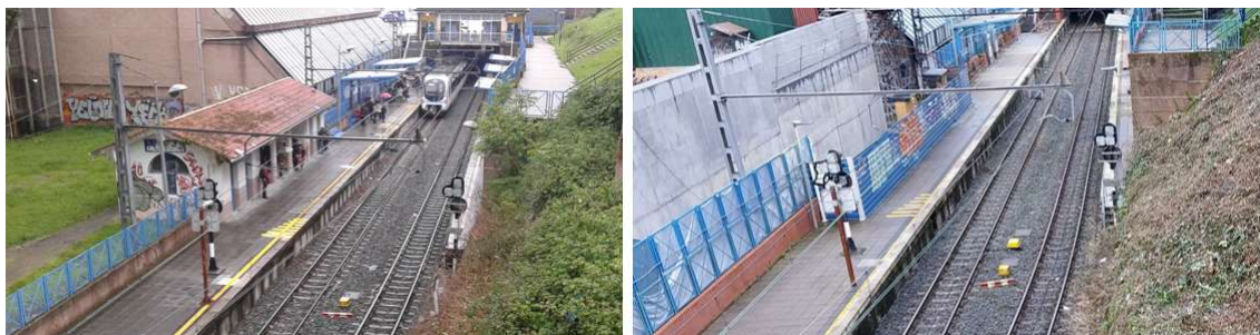
Ilustración 3 : A la izquierda, estado previo a las obras de Altza-Galtzaraborda y estado actual del andén sentido Donostia
