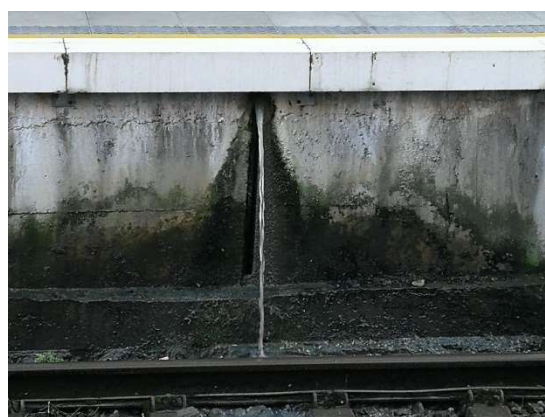
Ilustración 25: vertido de agua a la vía desde el andén dirección Hendaia
