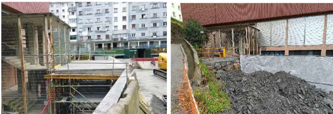
Ilustración 27: construcción de voladizos para evacuación definitiva del polideportivo hacia espacio exterior seguro
