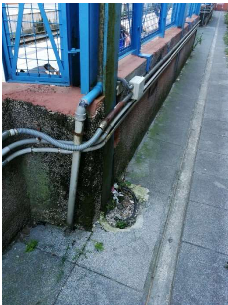
Ilustración 14: pasillo exterior entre andén y polideportivo (Se observan las canalizaciones de alumbrado del andén)
