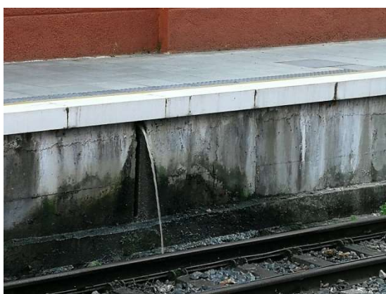
Ilustración 25: vertido de agua a la vía desde el andén dirección Hendaia
