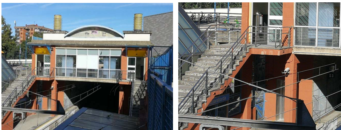
Ilustración 23: Escaleras de acceso a andenes
