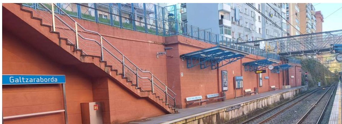
Ilustración 4: Muro de bloque del andén sentido Hendaia y pasarela provisional
