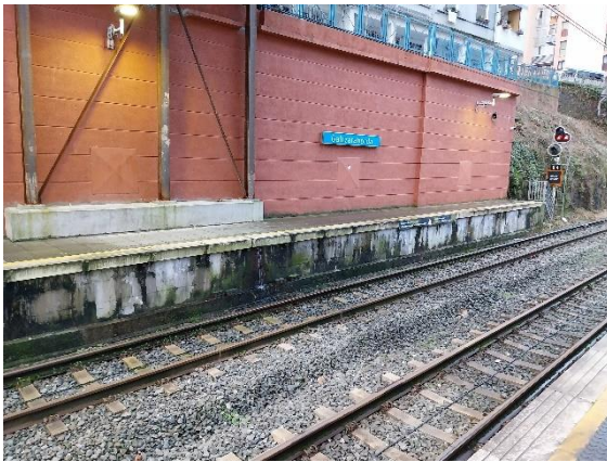
Ilustración 15: Apoyo de la pasarela provisional y filtraciones a través del andén Sur a la vía
