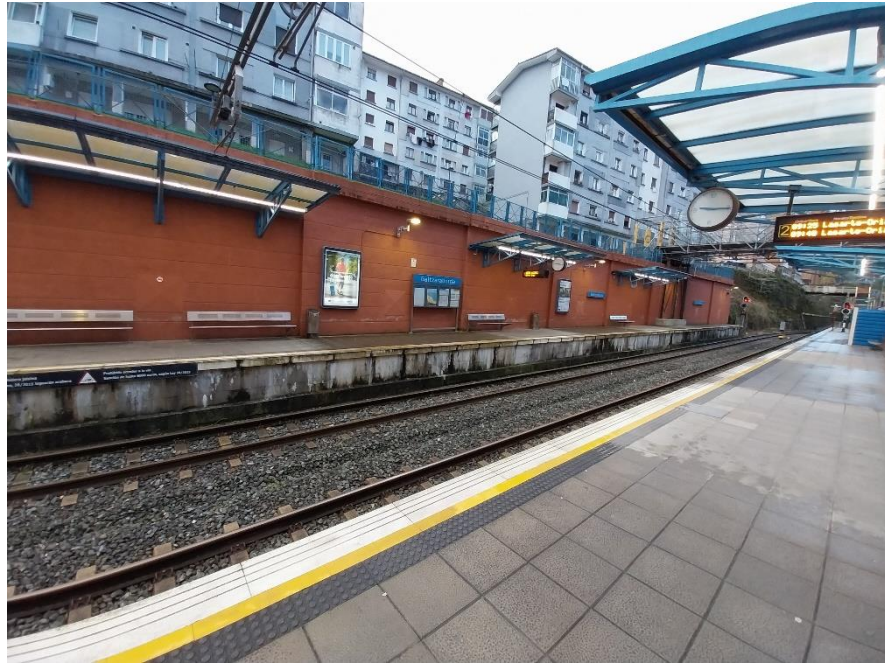
Ilustración 31: vista del andén sur desde el andén norte
