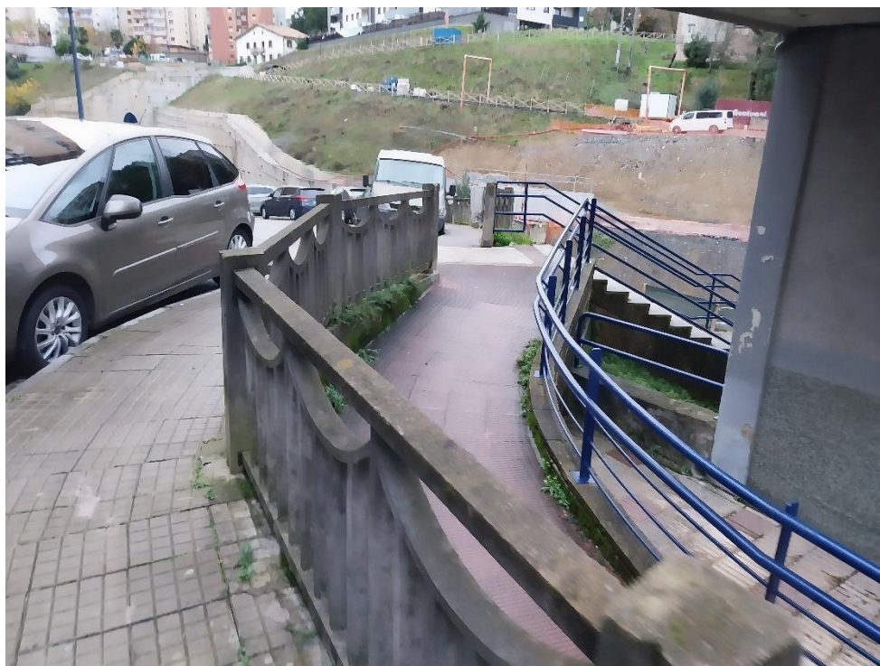
Ilustración 9: calle Apeadero y escaleras de acceso a paseo peatonal sobre muro andén
