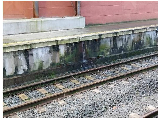
Ilustración 15: Apoyo de la pasarela provisional y filtraciones a través del andén Sur a la vía
