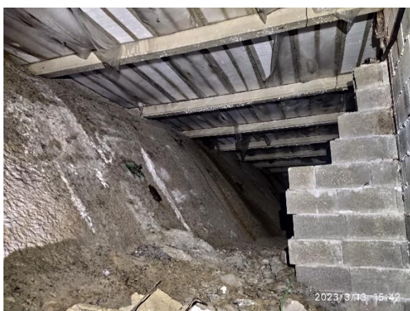
Ilustración 7: Vista interior del forjado ligero que conforma el paseo peatonal sobre muro andén dirección Hendaia. Se observan los contrafuertes de bloque y el talud bulonado.
