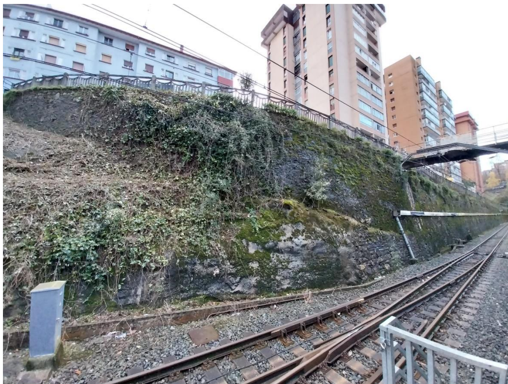
Ilustración 11: Talud bulonado bajo calle Apeadero. Al fondo, pasarela fuera de servicio
