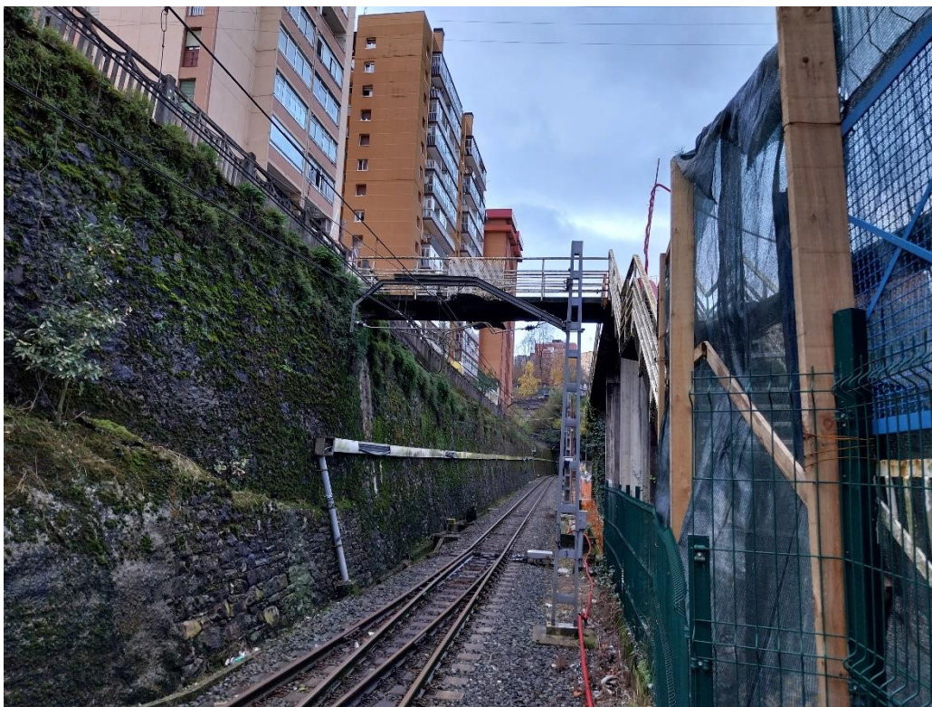
Ilustración 12: Pasarela fuera de servicio (a demoler por el tramo Altza-Galtzaraborda) y canaleta de conducción de fibra óptica sobre el talud.
