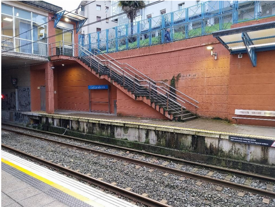
Ilustración 32: Escaleras andén Sur
