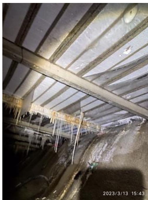
Ilustración 7: Vista interior del forjado ligero que conforma el paseo peatonal sobre muro andén dirección Hendaia. Se observan los contrafuertes de bloque y el talud bulonado.
