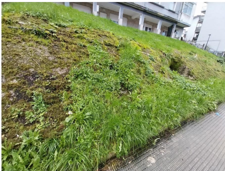
Ilustración 6: Bulonado exterior en talud sobre andén dirección Hendaia
