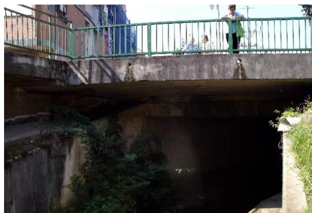
Figura 78. Cobertura río Granada en Bº Churruga en Ortuella
