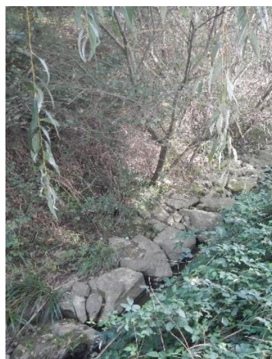
Figura 3. Aspecto tras la obra
