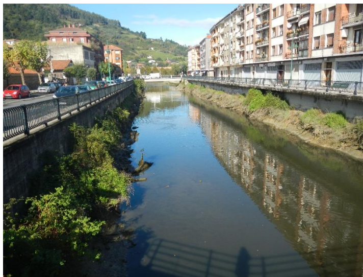
Figura 57. Tramo del río Oka encauzado a su paso por la zona urbana de Gernika
