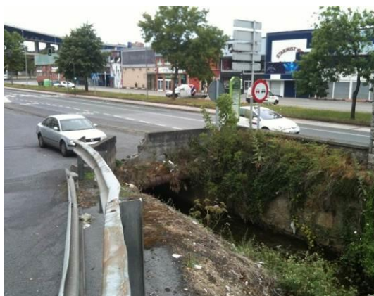
Figura 77. Cobertura río Granada en Trápaga
