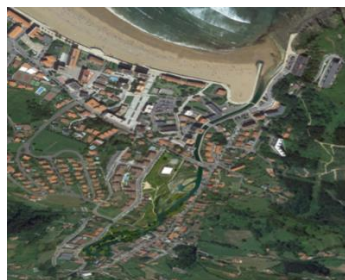
Figura 109. Infografía del proyecto, perspectiva aérea desde la desembocadura del río Estepona (SCIA SL)
