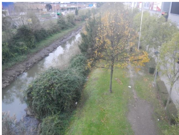
Figura 80. Camino de tierra existente en margen derecha donde se dispondrá mota de 0,5 - 1,2 m de alto
