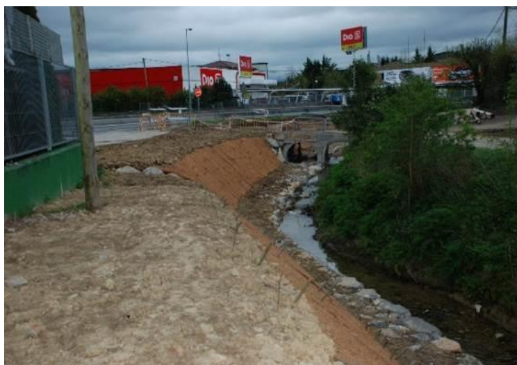
Figura 2. Ampliación por la margen derecha
