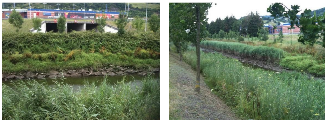
Figura 98. Río Galindo a la altura de Megapark. Zona alta del tramo objeto de análisis en la Fase 1
