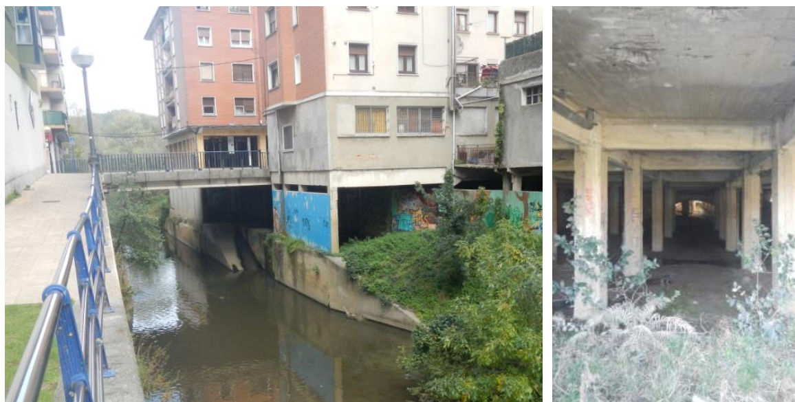
Figura 14. Edificios a demoler aguas a la altura de la calle Lauaxeta Olerkari y bajos de dichos edificios
