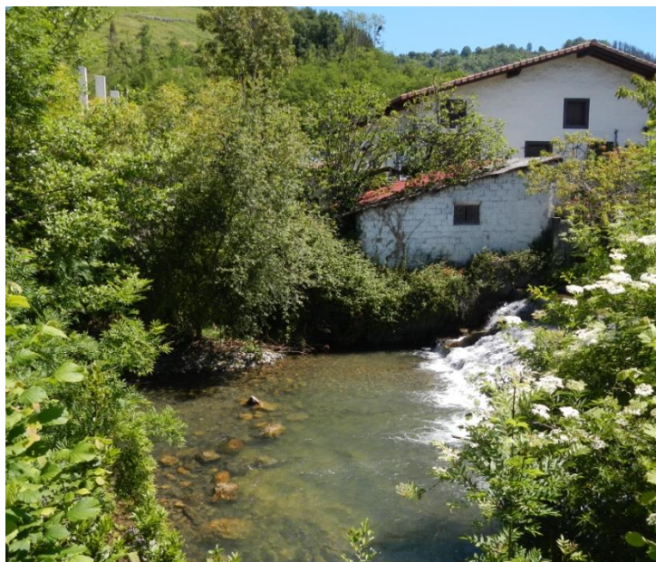
Figura 36. Entorno del río Errezil. Azud existente y vegetación de ribera en buen estado.
