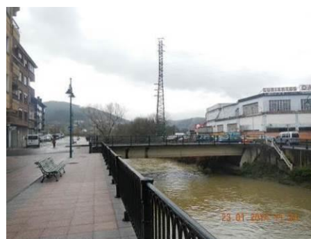
Figura 47. Puente de Rentería
