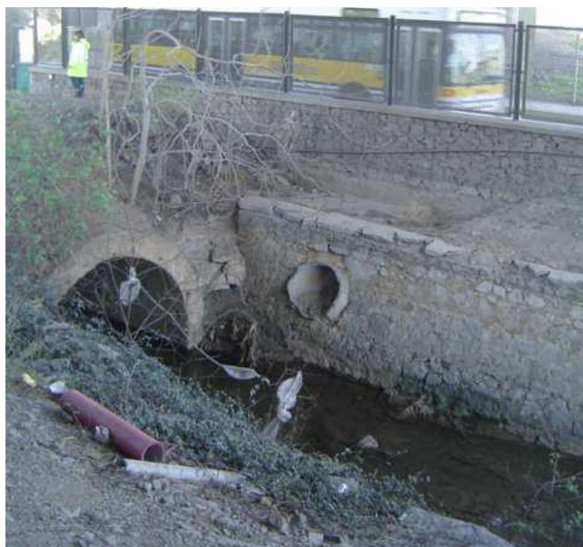
Figura 102. Cobertura del arroyo Granada a la altura de los pabellones de Bombardier
