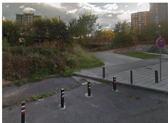
Figura 83. Zona de encuentro con la pasarela actual existente
