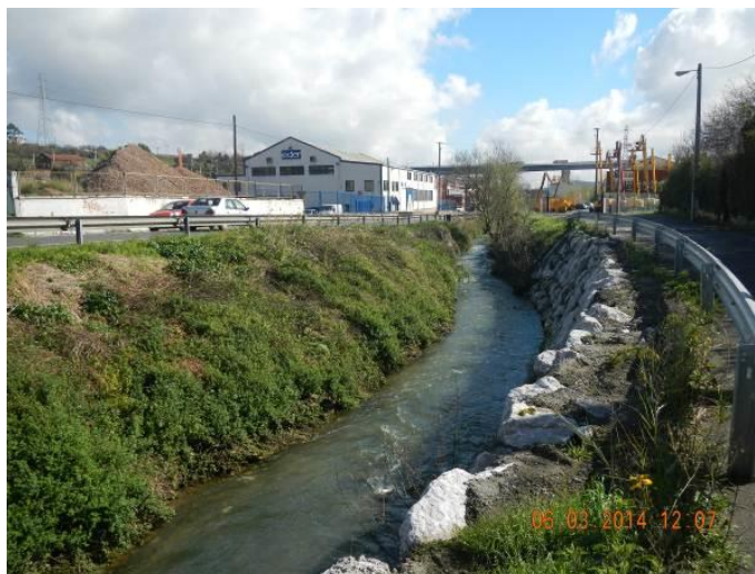
Figura 94. Zona de cauce a acondicionar
