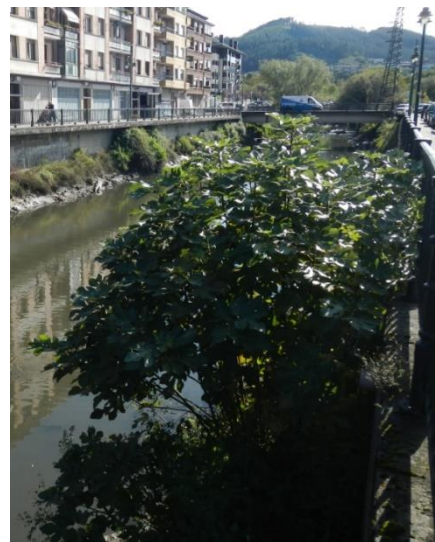
Figura 58. Higuera implantada en el muro lateral del tramo encauzado
