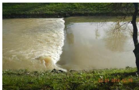
Figura 45. Azud de Urbieta
