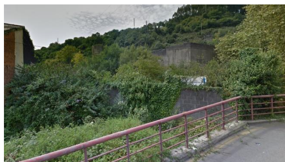
Figura 87. Pabellón y muro existente aguas arriba del puente de la calle Ametzaga
