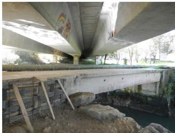
Figura 64. Zona de cierre del muro en MI bajo el paso de la BI-635.
