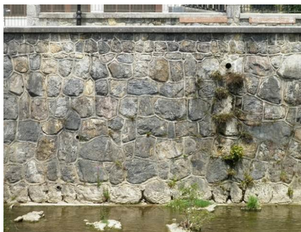
Figura 33. Vista de los tubos de drenaje, zona potencial para la nidificación del avión zapador.
