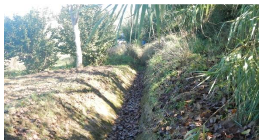
Figura 67. Canal paralelo al terraplén de la BI-635
