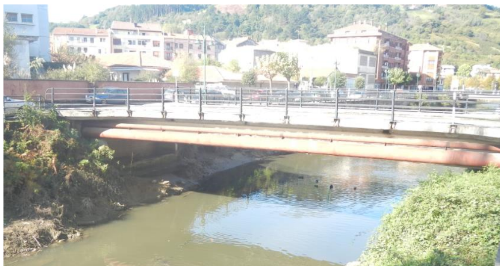
Figura 62. Puente de Zubialde Kalea a eliminar.
