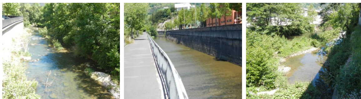
Figura 34. Vista de los tubos de drenaje, zona potencial para la nidificación del avión zapador.
