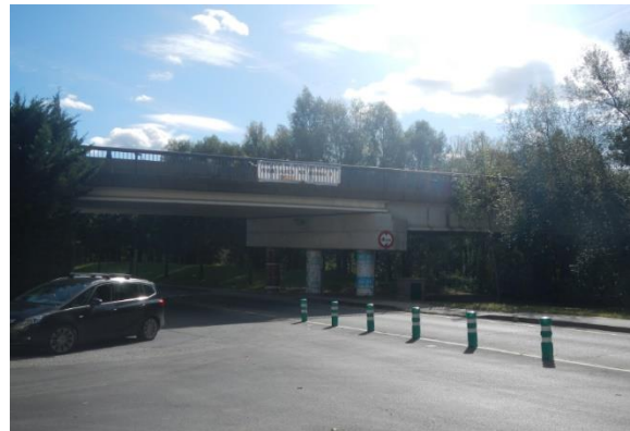
Figura 70. Zona de acceso del agua PK 4+800
