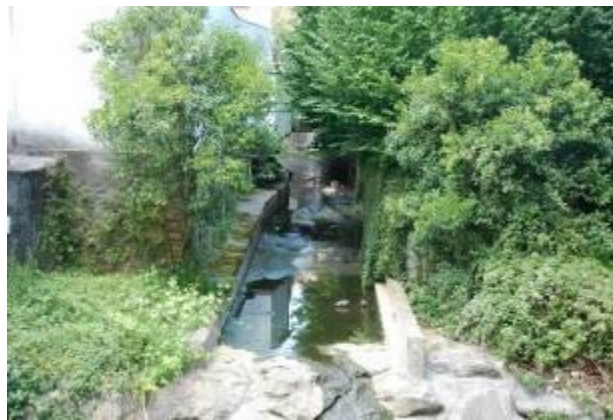
Foto 14 Arroyo Aldaikoerreka, también canalizado, en la desembocadura en el Nerbioi.
