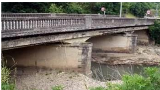
Foto 68 Puente de la GI-2632 a sustituir.
