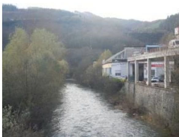
Foto 71 Tramo entre el puente de Matxiategi y campo de fútbol. Márgenes modificadas con escasa vegetación, especialmente en margen derecha.
