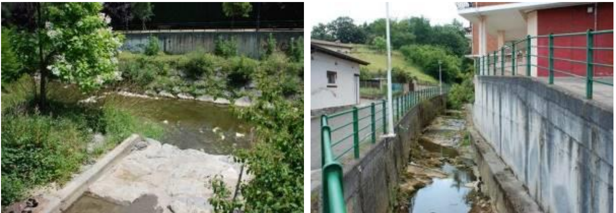
Foto 13 Arroyo Sapuela, en la desembocadura en el Nerbioi (en la imagen de la izquierda se observa la cobertura del cauce) y aguas arriba, encauzado.
