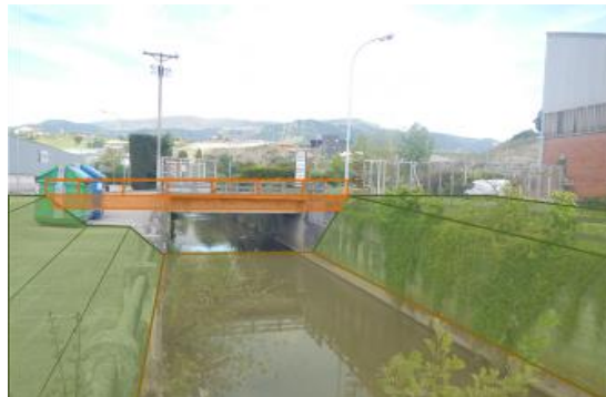
Foto 4. Paso a sustituir en zona industrial.
