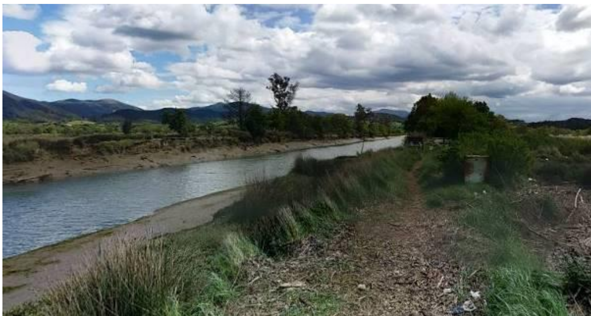
Foto 37 Canal del Corte de la Ría limitado entre motas a ambos lados.
