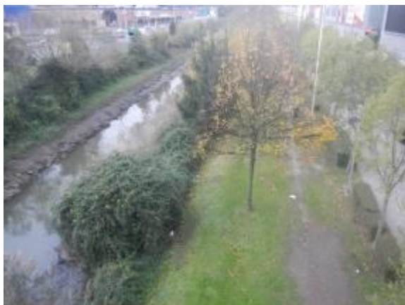
Foto 51 Camino de tierra existente en margen derecha donde se dispondrá mota de 0,5 - 1,2 m de alto.
