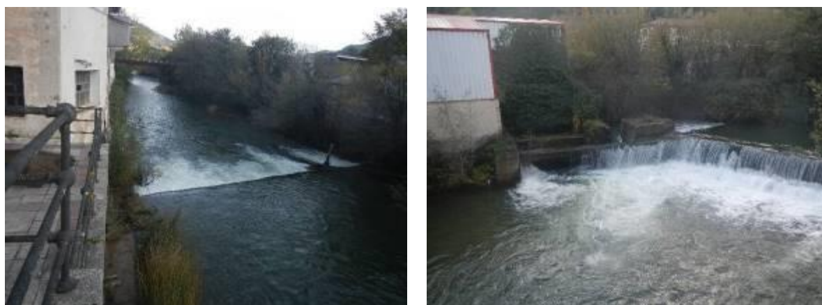
Foto 38 Azudes sucesivos de la ferrería de Laiseca. El azud de aguas abajo del PK 31+254 (izda.) se elimina, el azud de aguas arriba, se rebaja 1 m para mantener la derivación lateral donde se conserva la toma y vertido.
