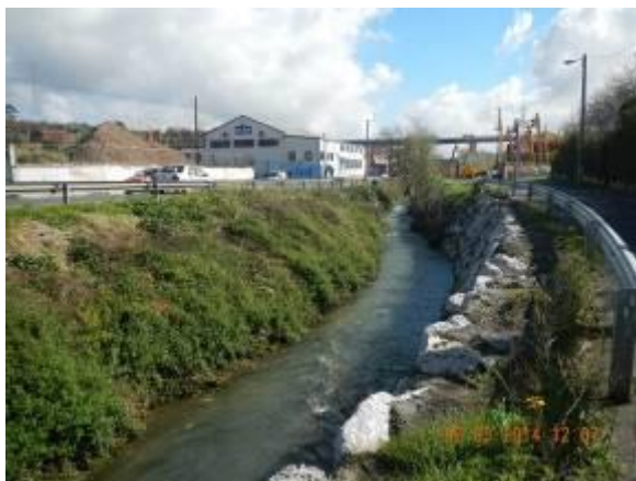
Foto 61 Zona de cauce a acondicionar.
