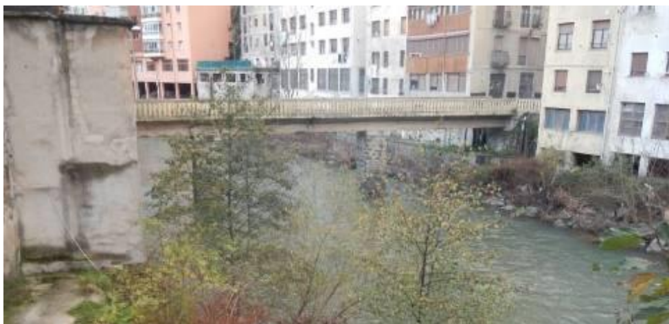
Foto 72 Pasarela a sustituir. PK 2+060.
