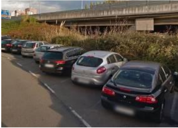
Foto 53 Zona de cierre con la A-8 mediante mota.
