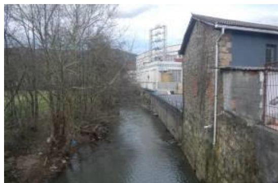
Foto 8. Pabellones aguas abajo de la BI-3333.
