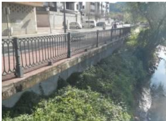
Foto 28 Zona a disponer muro en MD aguas arriba del puente de la c/Zubialde.
