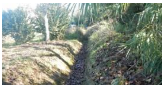
Foto 30 Canal paralelo al terraplén de la BI-635.
