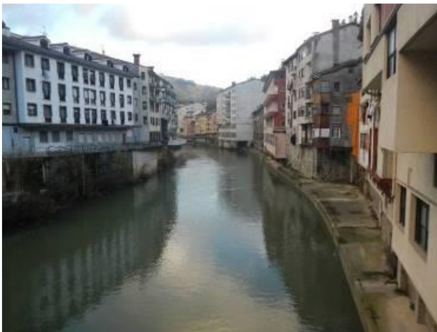
Foto 74 Núcleo urbano de Soraluze, edificaciones que flanquean el cauce.
