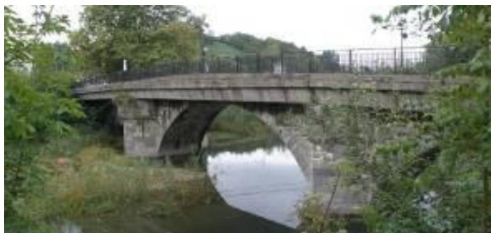
Foto 1. Puente de Ergobia.
