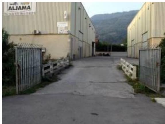
Foto 62 Pasarela de acceso al taller Aljama.
