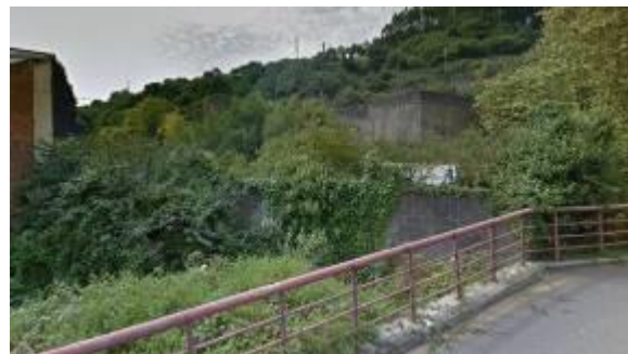
Foto 58 Pabellón y muro existente aguas arriba del puente de la calle Ametzaga.
