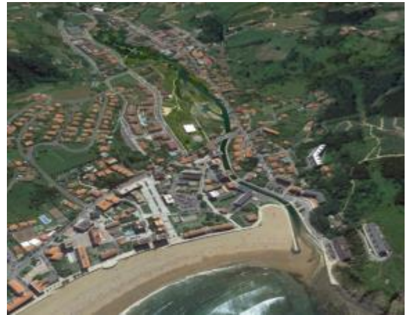
Figura 107 Infografía del proyecto, perspectiva aérea desde la desembocadura del río Estepona (SCIA SL).
