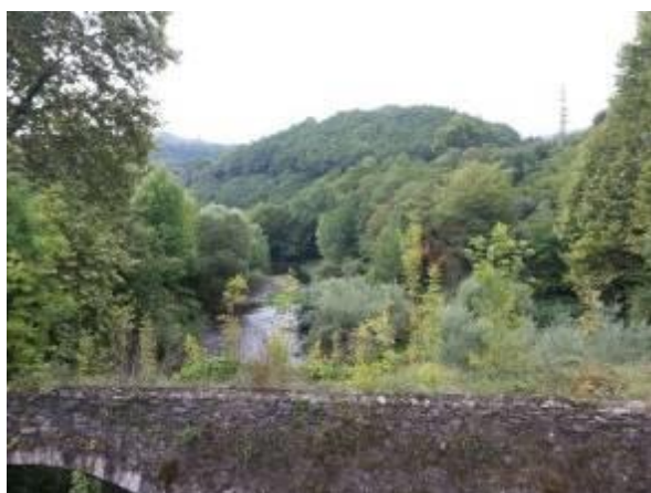
Foto 70 Vegetación de ribera en buen estado aguas arriba del puente Amillaga. En primer plano el puente viejo de Amillaga en desuso que se prevé demoler.
