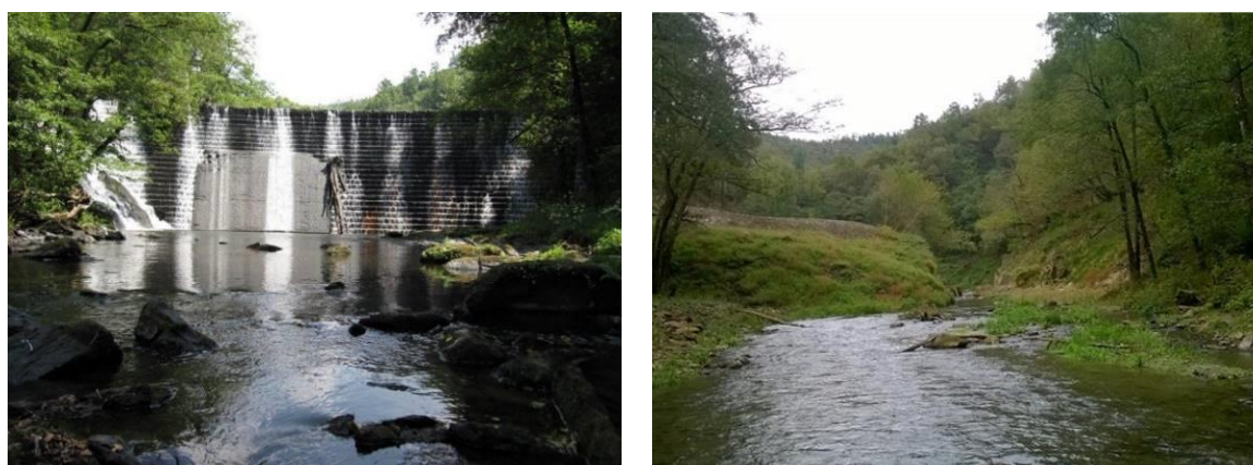
Figura 35. Fotografías de la presa de Inturia (río Leitzaran) antes y después de su demolición. La presa tenía una altura de 12,5 metros y está ubicada en la ZEC Río Leitzaran ES2120013.
