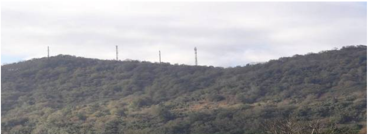
Figura 106: Antenas de telecomunicación en la cima de Mendibeltz.
