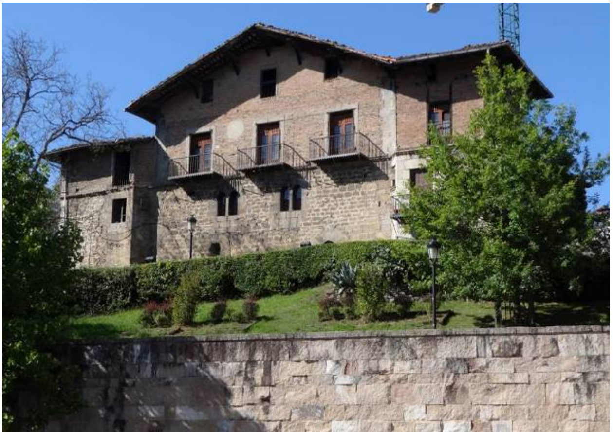
Figura 35: Casa Torre Balda (Azkoitia).
