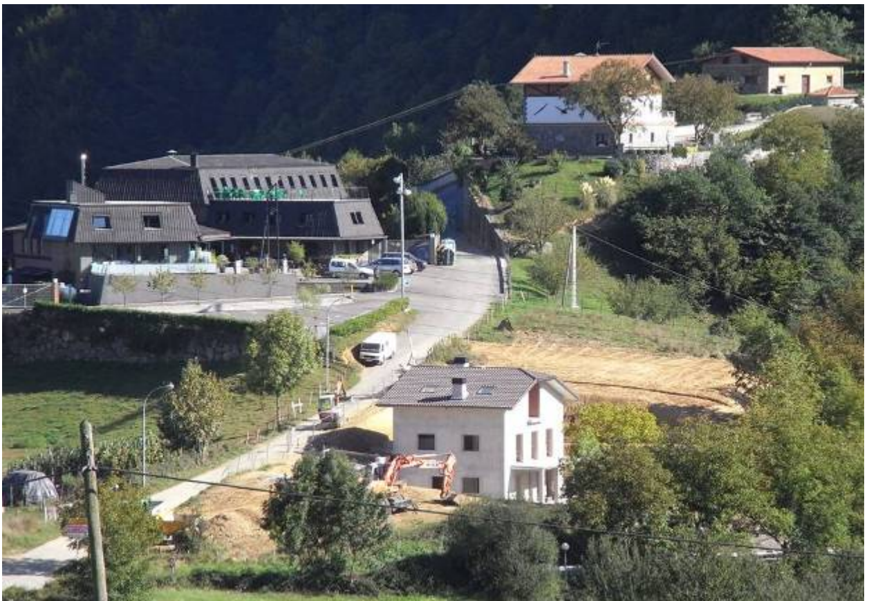
Figura 98: Viviendas unifamiliares en el periurbano de Azkoitia.
