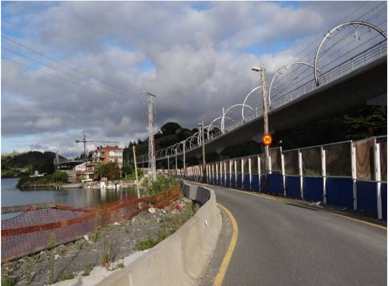
Figura 104: Puente de la autopista A-8 al cruzar la ría del Oria.
