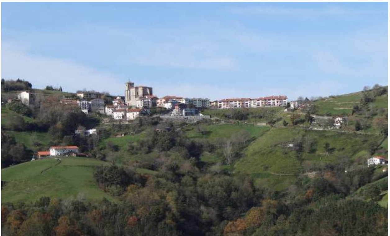
Figura 77: Vista del núcleo de Aia.
