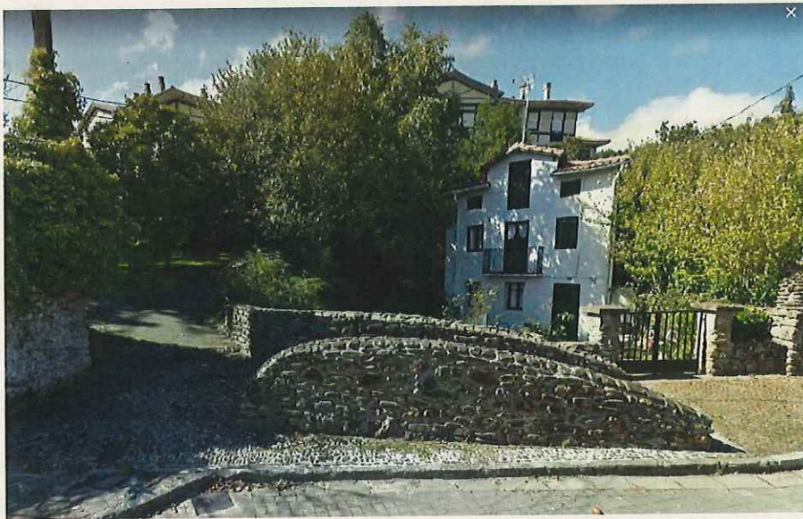
Puente de Errotatxu y río Amunategi soterrado
