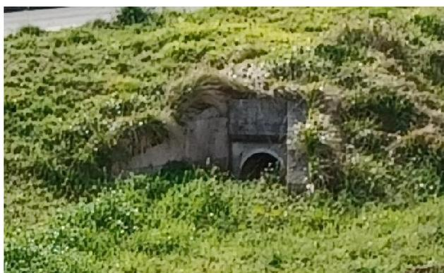
*Ilustración 4. ODT pluviales*
