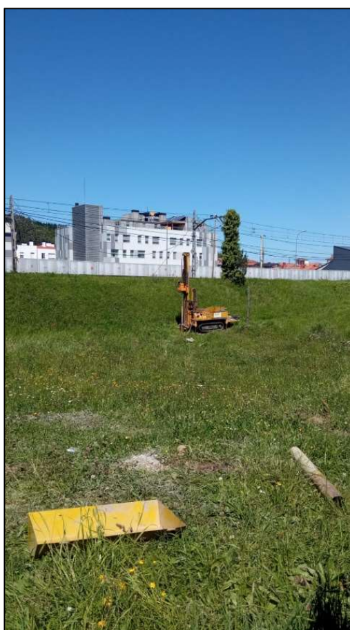
Figura 2. Emplazamiento del sondeo SM-1.
