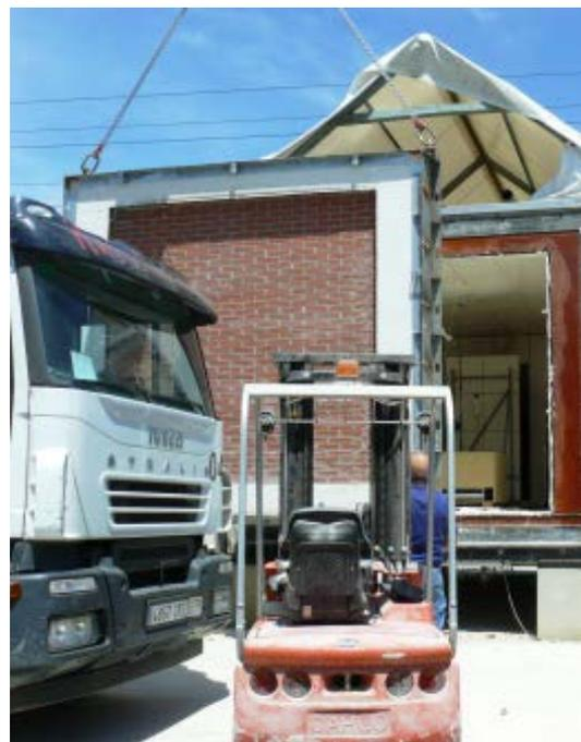
Colocación del muro en Célula Paslink
