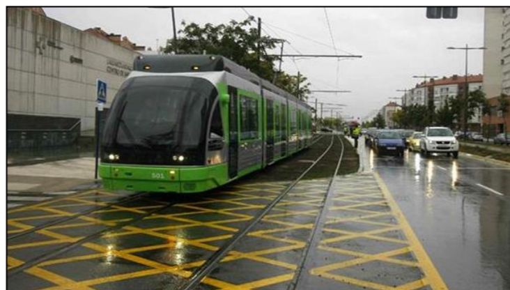
28. Irudia. Asfaltoko estaldura Vitoria-Gasteizko tranbian.
