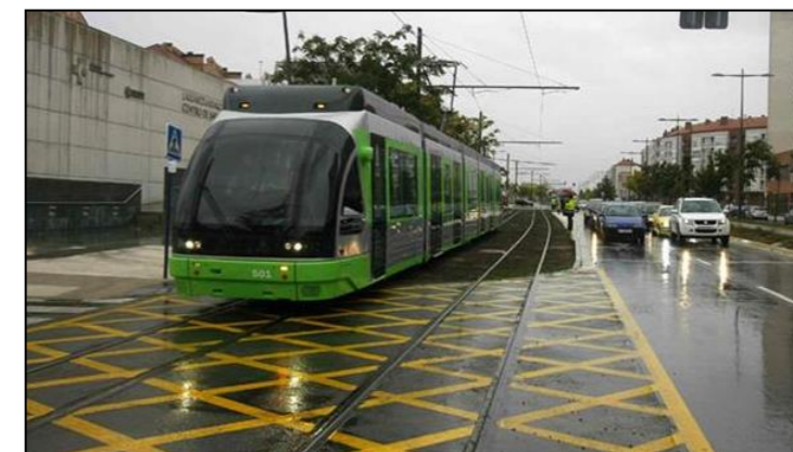
Figura 28. Revestimiento asfáltico en la línea existente en Vitoria.
