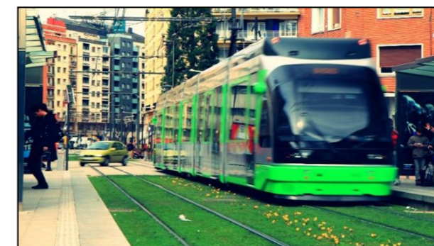
Figura 26. Revestimiento con césped en la línea existente en Vitoria.
