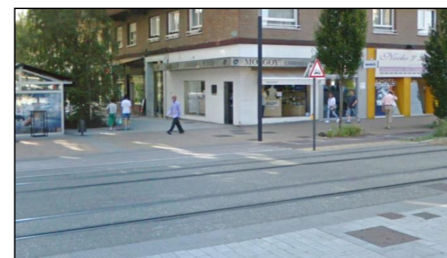
Figura 27. Revestimiento con asfalto fundido pulido en la línea existente en Vitoria.
