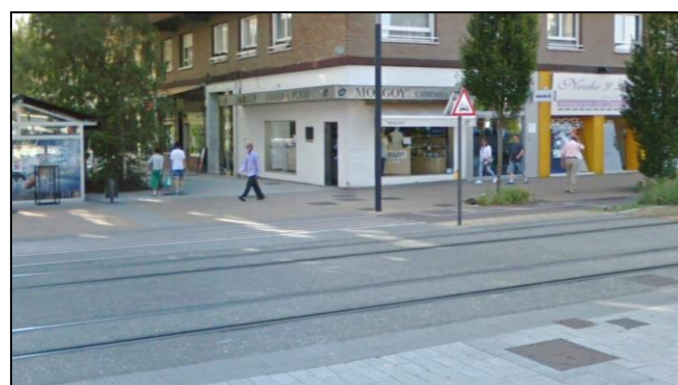
27. Irudia. Urtutako asfaltoko estaldura Vitoria-Gasteizko tranbian.
