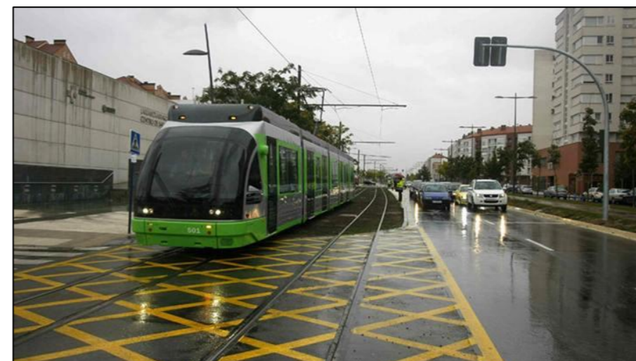
Figura 9. Revestimiento asfáltico en la línea existente en Vitoria-Gasteiz.
