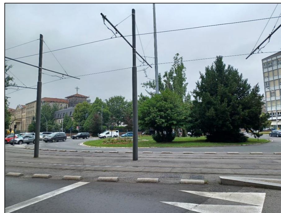
Figura 8. Revestimiento con asfalto fundido pulido en la línea existente en Vitoria-Gasteiz.
