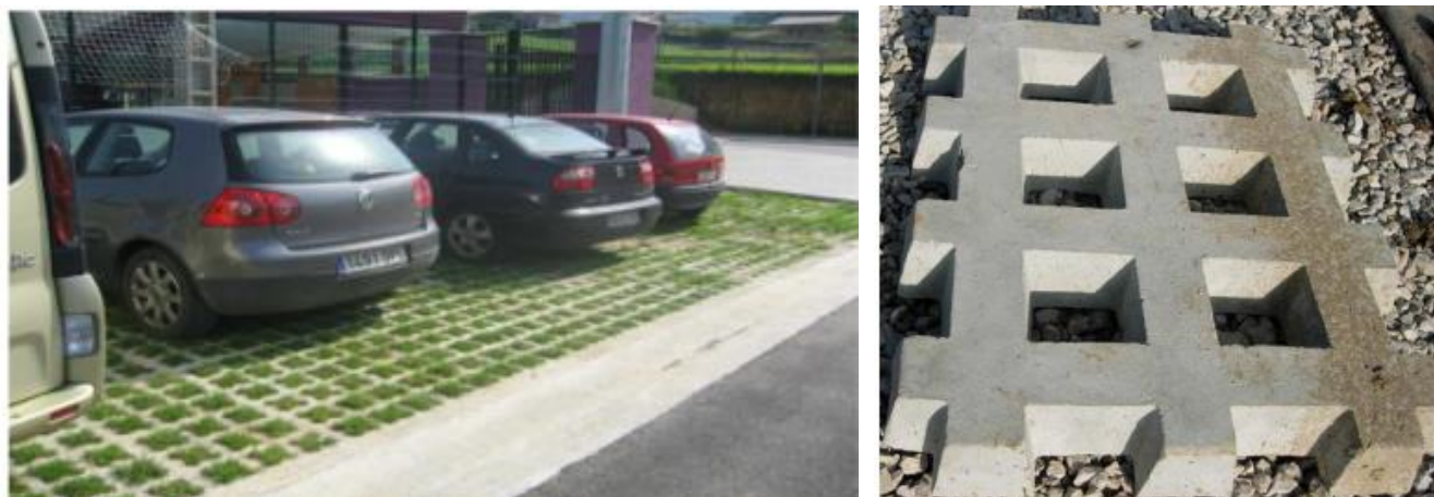
Figura 4: Pavimento permeable de hormigón armado. Fuente: Paviprint
