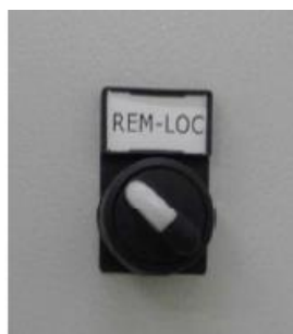
Figura 3. Selector mando local-remoto
