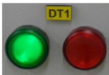
Figura 5. Pilotos de señalización de estado de tensión, para detector de tensión
