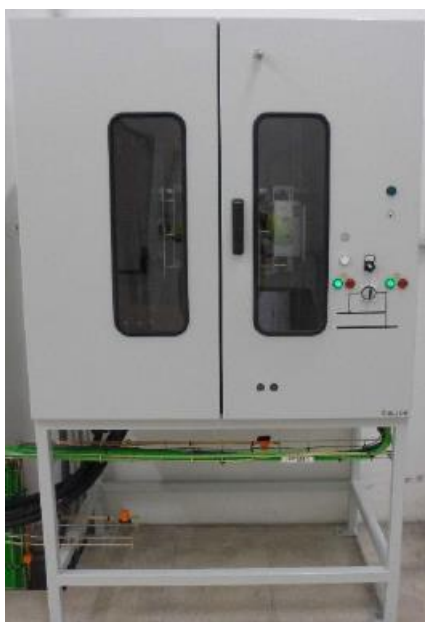
Figura 1. Ejemplo ruptor de catenaria instalado en la red de ETS.
