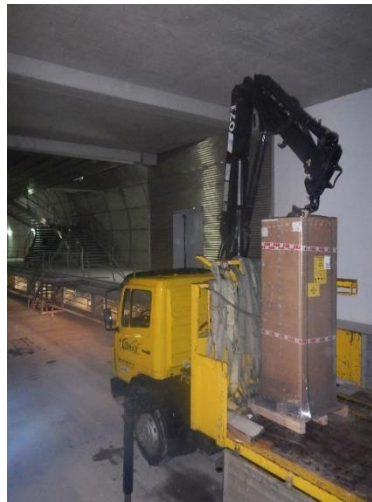
Figura 2. Envío a obra de cuadros +eléctricos
