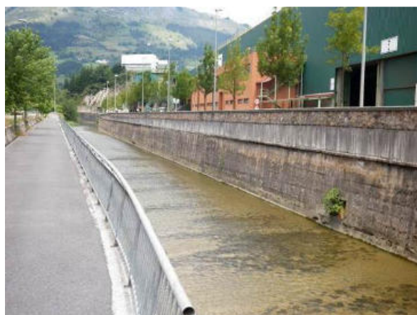
Figura 60.- Tramo central del río
