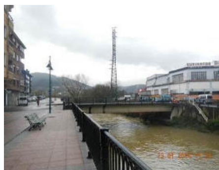
Figura 81.- Puente de Rentería
