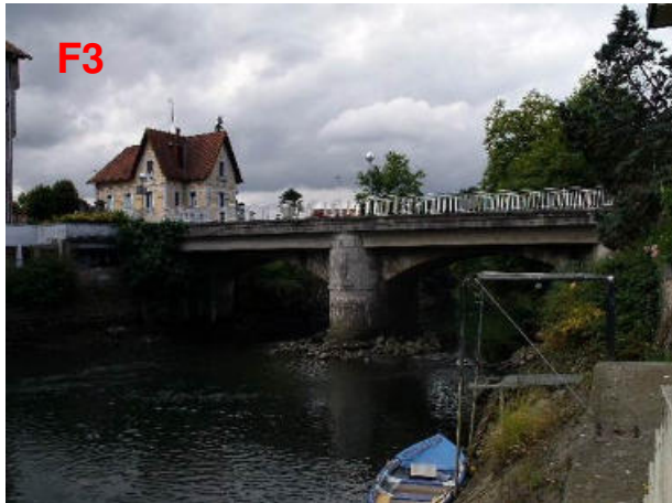
Figura 21.- Puente actual de Martutene
