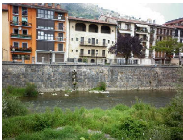
Figura 54.- Margen izquierdo del río, donde se plantea como actuación la ampliación del cauce en 5 m en un muro donde posiblemente nidifique el avión zapador.
