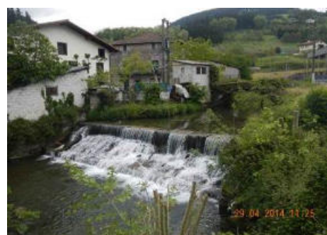
Figura 62.- Azud a demoler
