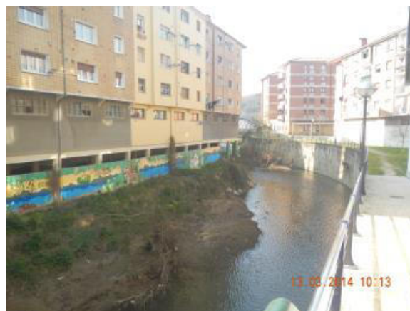
Figura 34.- Vista hacia a/arriba desde el paso de edificios en margen derecha y sección del cauce
