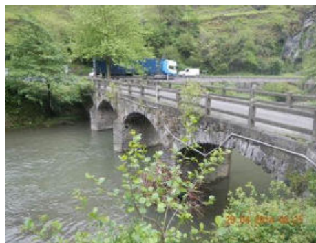
Figura 51.- Puente a sustituir aguas abajo de la GI-631
