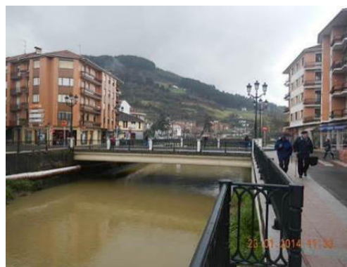
Figura 80.- Encauzamiento actual y puente de San Bartolomé
