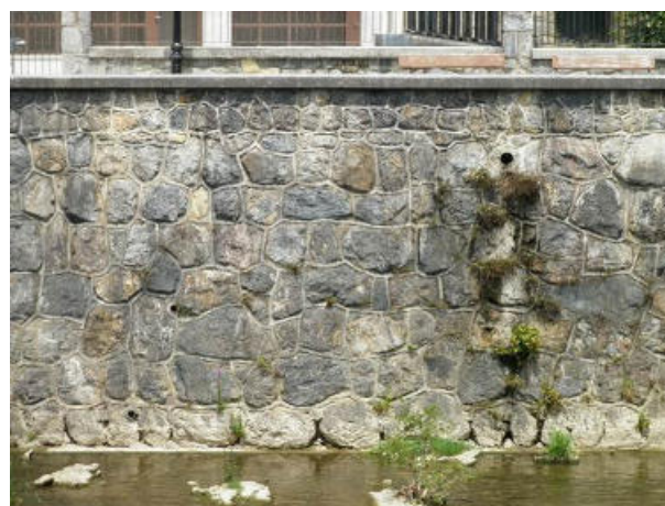
Figura 55.- Vista de los tubos de drenaje donde nidifica la especie.
