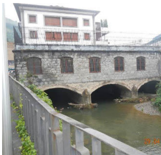
Figura 58.- Entrada a la cobertura con edificio de viviendas sobre la misma
