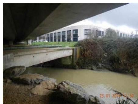
Figura 82.- Zona de cierre del muro en MI bajo el paso de la BI-635
