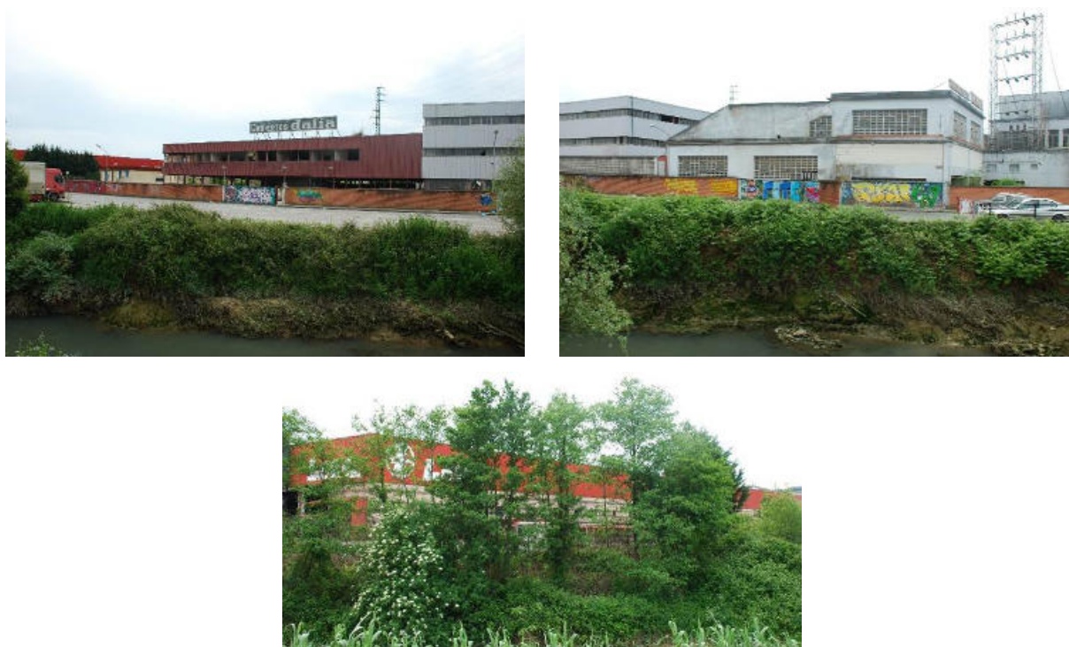
Figura 94.- Río Oka a su paso por el polígono industrial junto al centro urbano, frente a “Cubiertos Dalia”. Zonas de aliseda en la margen izquierda.
