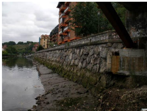
Figura 2.- Margen izquierda aguas arriba del hoy sustituido puente de ETS
