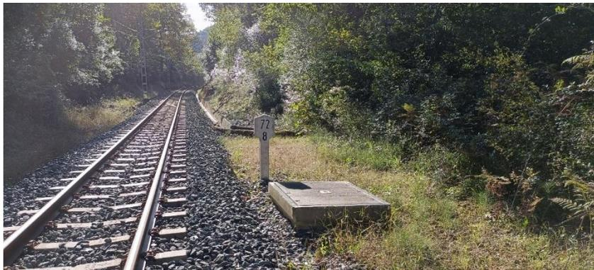
PK 72+800. Arqueta de comunicaciones en margen derecha de la vía. Afección a canalizaciones en margen derecha de vía S.A. 101, S.A. 102 y S.A. 103.
