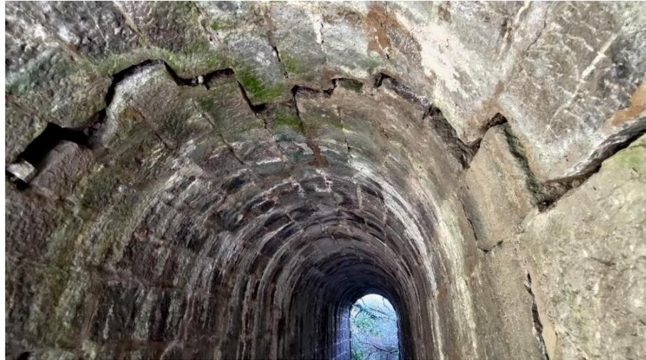
Vista de la grieta descrita. La apertura de la grieta aumenta de zócalo de hastial a clave de bóveda, lo que es compatible con un giro de vuelco del muro de conetención del relleno de la plataforma ferroviaria.
