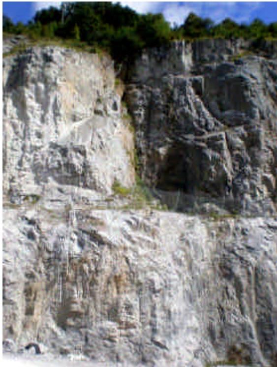
Esta zona presenta una fractura vertical importante en su zona superior, sobre la pantalla dinámica existente pero no se le observa una continuidad en la zona inferior del talud.
