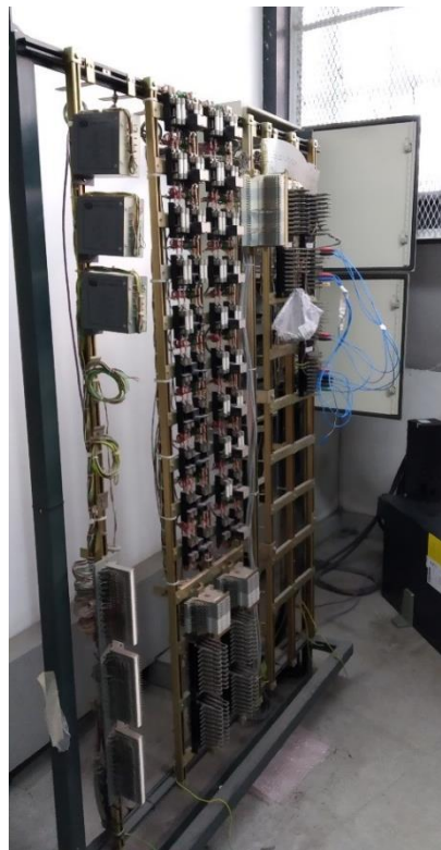
Fotografía 9. Repartidor abierto
