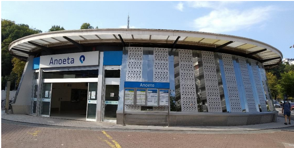
Fotografía 1. Acceso a vestíbulo
