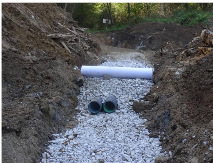
Figura 7.2.- Dren en el punto del cruce de la vaguada.
