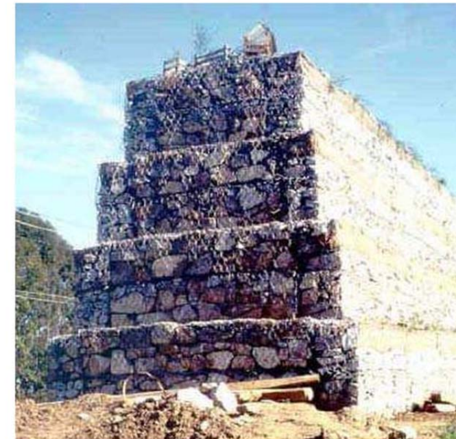
Fotografía de pantalla conformada únicamente por materiales pétreos
