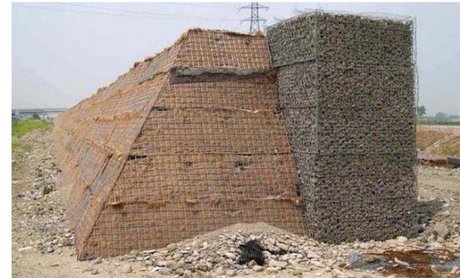
Fotografía de pantalla conformada por materiales pétreos + relleno estructural
