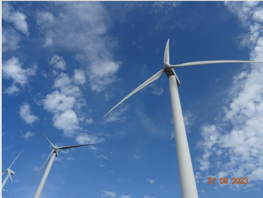
Fotografía 9. Detalle de las palas de los aerogeneradores del parque eólico Elgea-Urkilla.
