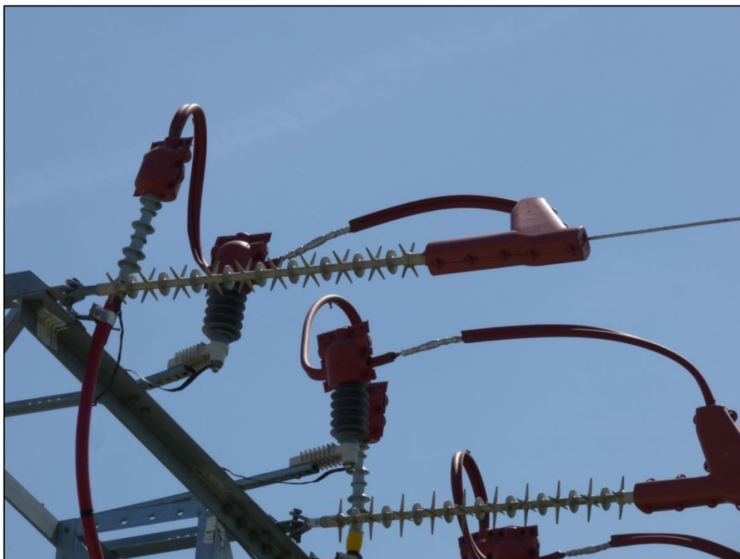
Figura 12. Torreta de conversión aéreo/subterráneo y OCR (nº 9001, Bi-78045) que mantiene las electroválvulas en la cogolla del armado y puentes flojos dominantes solo parcialmente aislados. Las electroválvulas deberían reinstalarse en un travesaño inferior.
