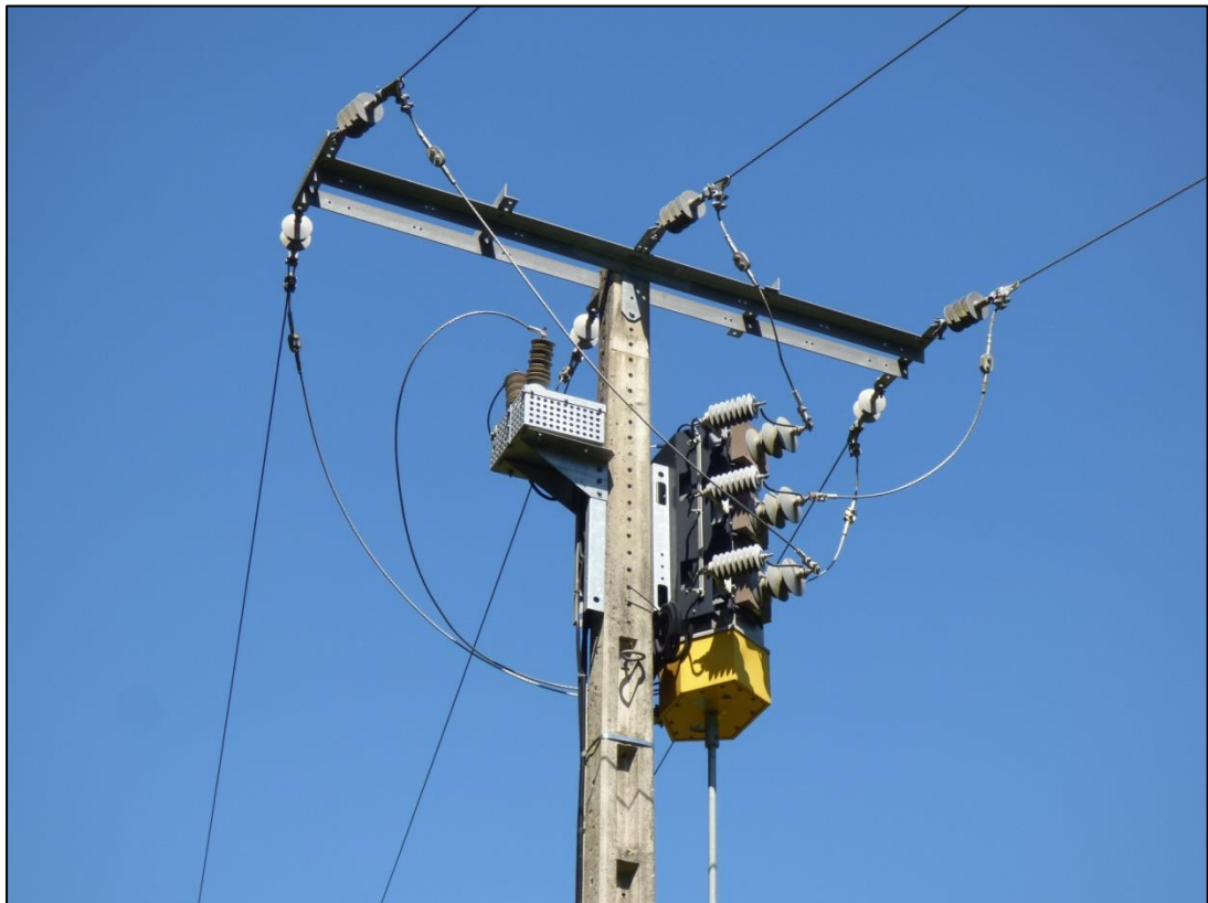
Figura 32. Apoyo de maniobra nº 5438 (Vi-13127) de la derivación al puerto de Altube que se mantiene sin remodelar; con cadenas de amarre de composite de menos de 1.0 m y las bajantes al OCR sin aislar.
