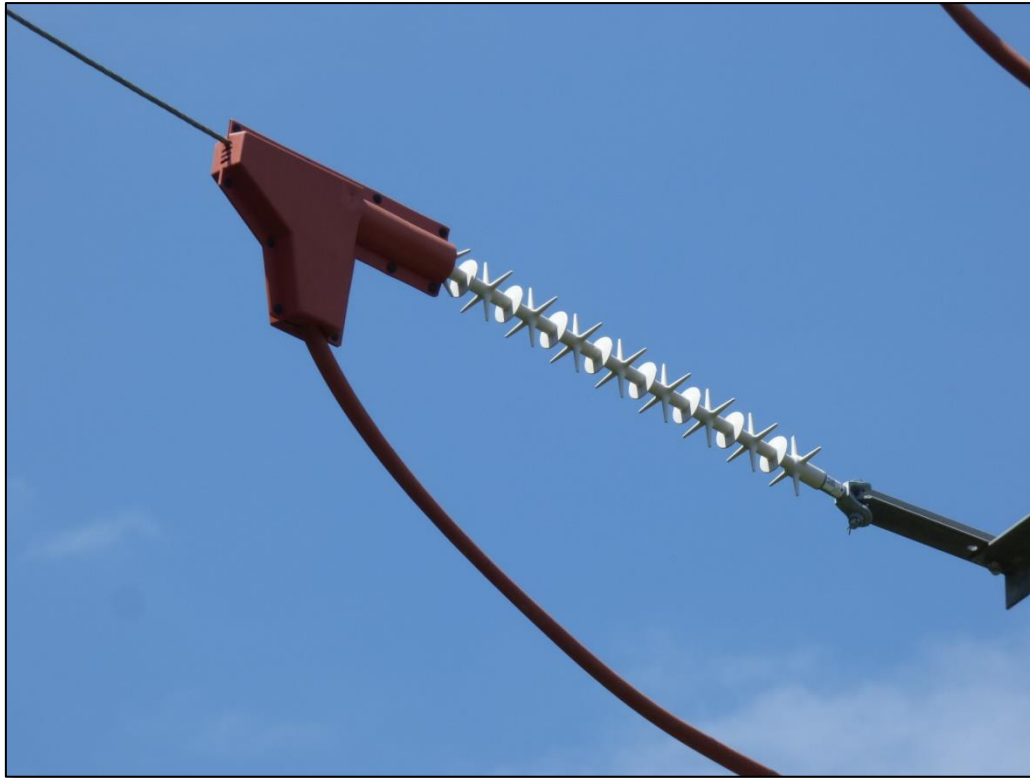
Figura 44. Cadena de amarre anti-posada, tipo "avifauna", complementada con cubregrapas preformados.
