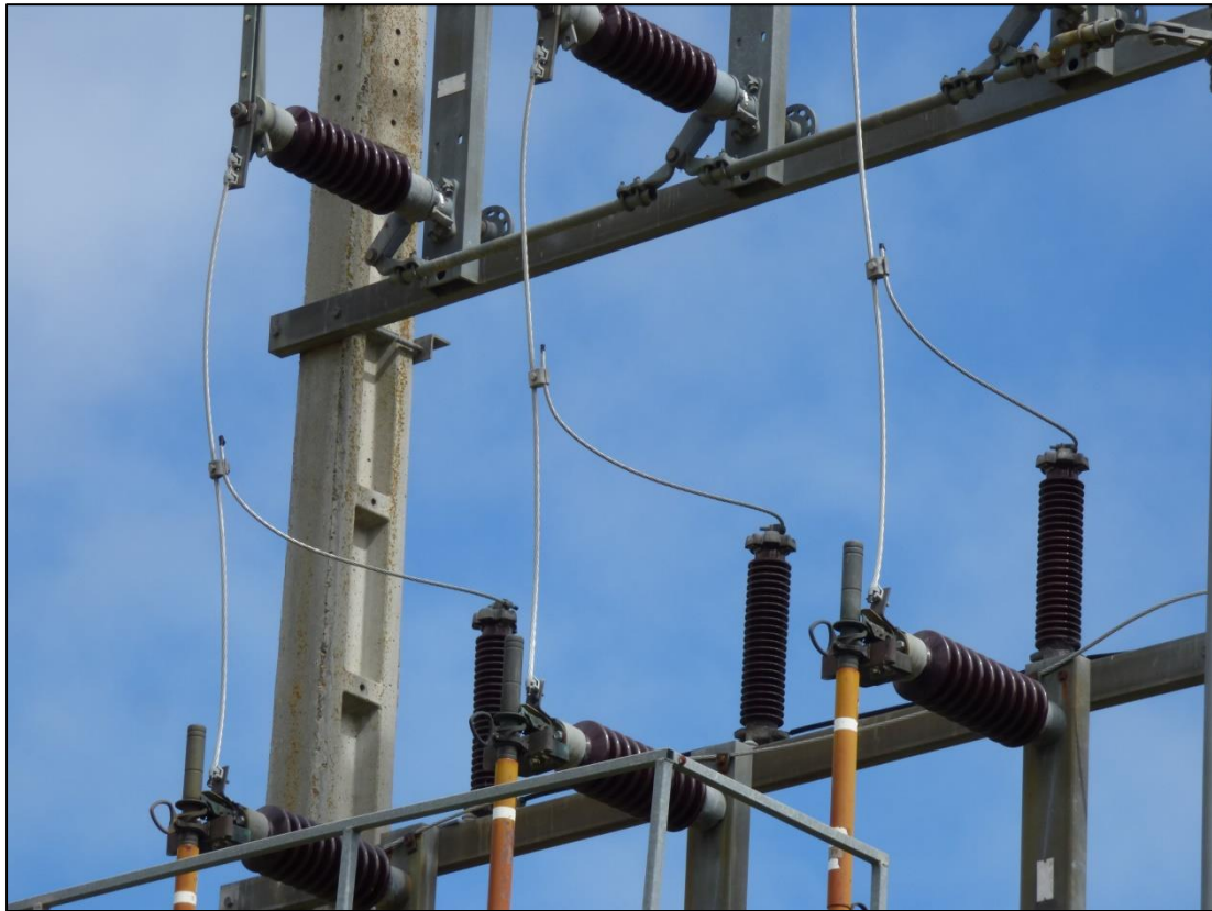
Figura 35. El apoyo de fin de línea nº 47 de la Der. al Bco. Tropera presenta los puentes a los seccionadores, a los fusibles, a las válvulas y al CTi sin aislar y las válvulas y los bornes del transformador de intemperie sin proteger.
