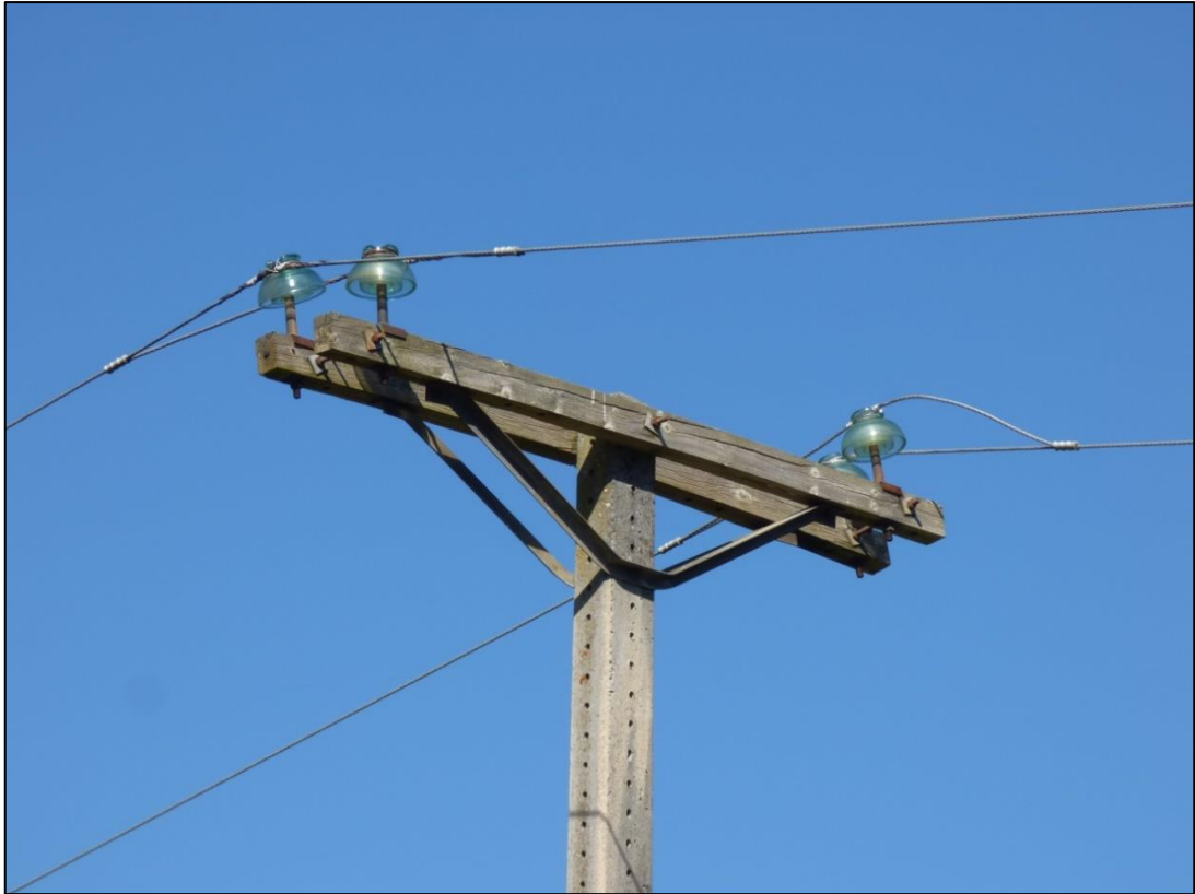
Figura 32. Apoyo de maniobra nº 5438 (Vi-13127) de la derivación al puerto de Altube que se mantiene sin remodelar; con cadenas de amarre de composite de menos de 1.0 m y las bajantes al OCR sin aislar.
