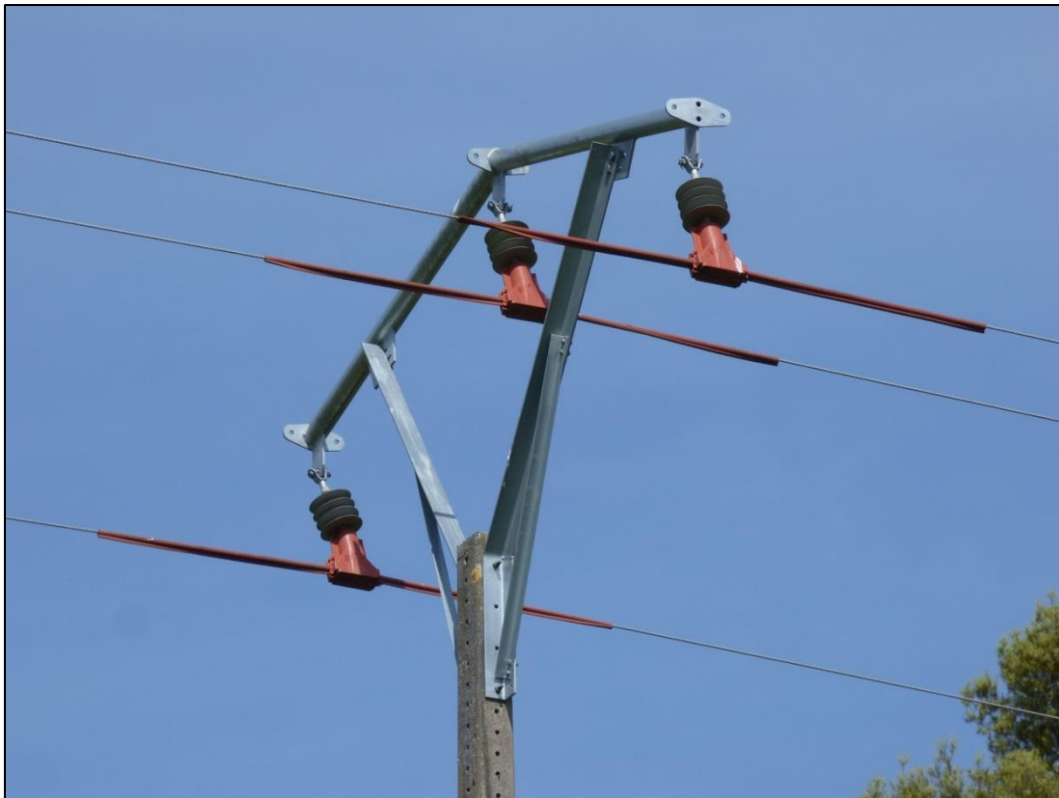
Figura 12. Torreta de conversión aéreo/subterráneo y OCR (nº 9001, Bi-78045) que mantiene las electroválvulas en la cogolla del armado y puentes flojos dominantes solo parcialmente aislados. Las electroválvulas deberían reinstalarse en un travesaño inferior.
