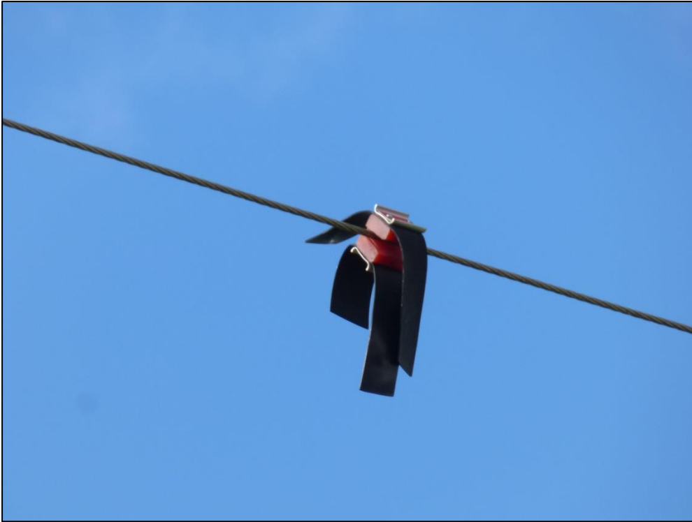
Figura 52. Detalle de las balizas salvapájaros ("X" de neopreno) utilizadas en la señalización de la Der. al caserío de Lacorzana (Línea 13.2 kV de Treviño).
