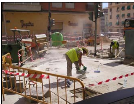
4.6. irudia – Materiala lehorrean ebakitzeak PM 10 asko sortzen du
