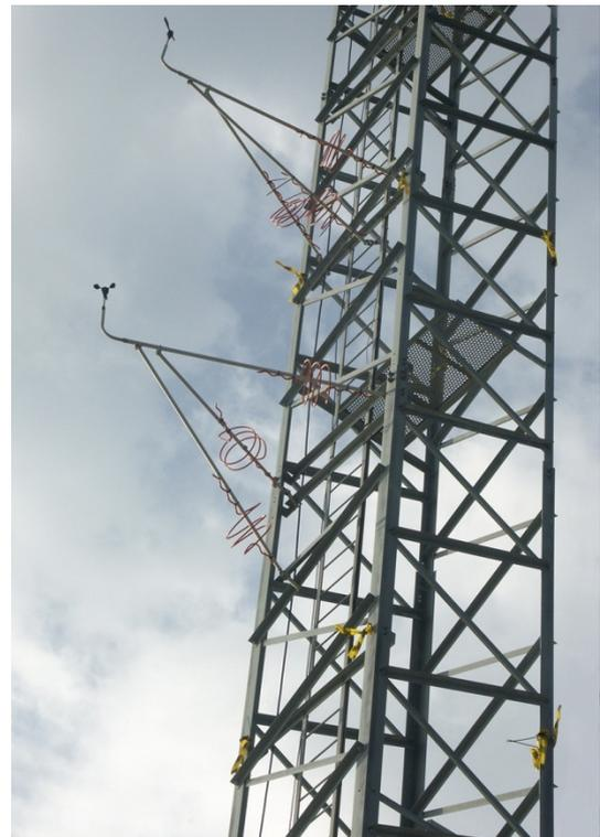
Figura 9. Cintas de plástico y espirales salvapájaros en la torre de medición para evitar que el halcón la use como posadero.
