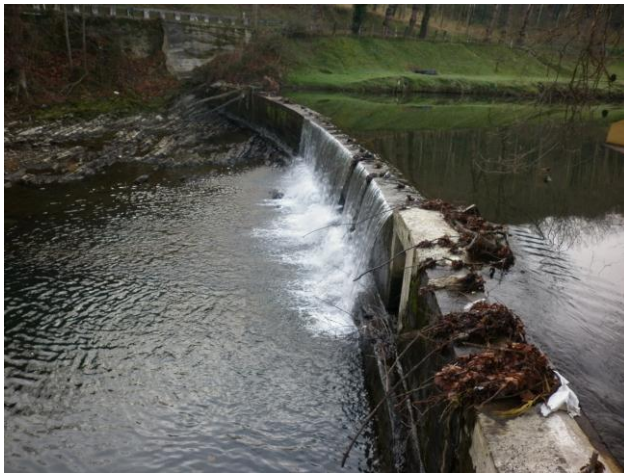
Foto 20. Azud C.H. Altuna Txiki, Q=3,35 \text{ m}^3/\text{s}
