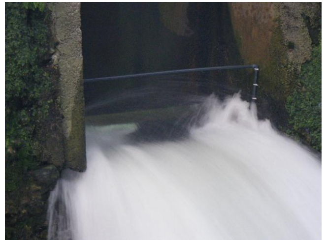
Foto 8. Salida bypass y antena 4 de detección
