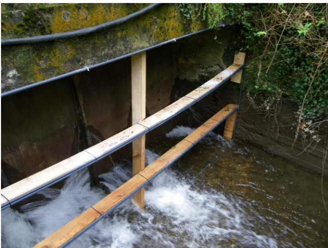
Foto 5. Detalle antenas 1, 2 y 3 en toma
