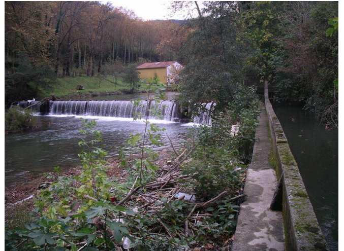
Foto 2. Azud y toma del canal en margen izda
