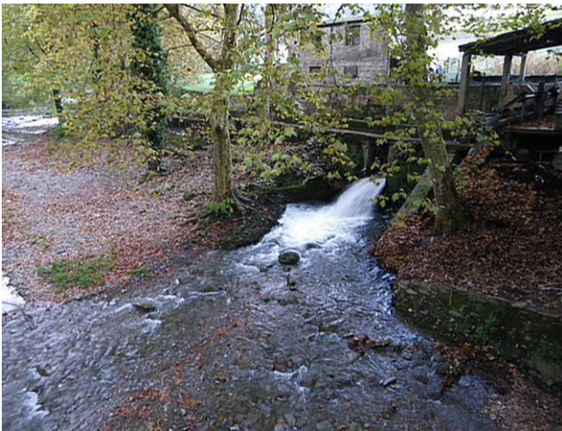
Foto 13. Salida del bypass-aliviadero al final del canal
