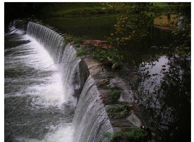
Foto 23. Azud C.H. Altuna Txiki, Q=3,91 \text{ m}^3/\text{s}
