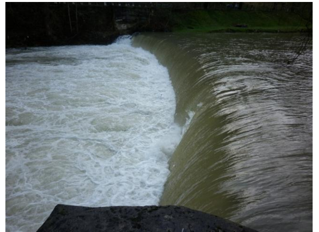
Foto 21. Azud C.H. Altuna Txiki, Q=47,79 \text{ m}^3/\text{s}
