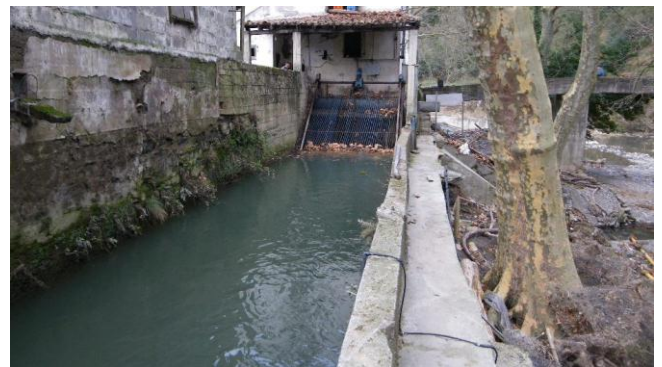
Foto 10. Fin del canal, rejilla al fondo
