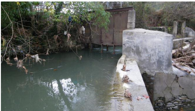
Foto 3. Toma – inicio canal de derivación
