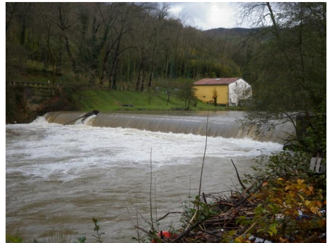
Foto 19. Azud C.H. Altuna Txiki, Q=43,98 \text{ m}^3/\text{s}
