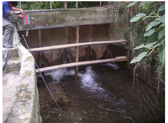
Foto 4. Montaje de Antenas 1, 2 y 3 en toma
