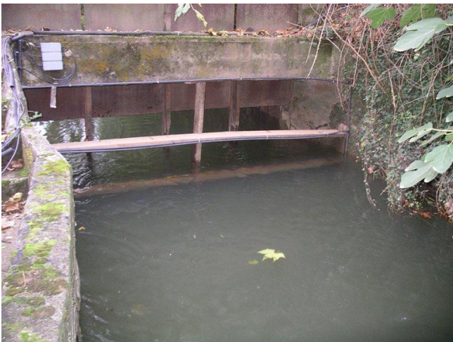
Foto 15. Antenas 1, 2 y 3 en toma, central en funcionamiento
